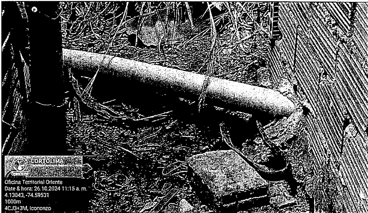
Fotografía No 8. Instalaciones de PVC que conducen las aguas porcícolas hasta alcantarilla sobre la vía
