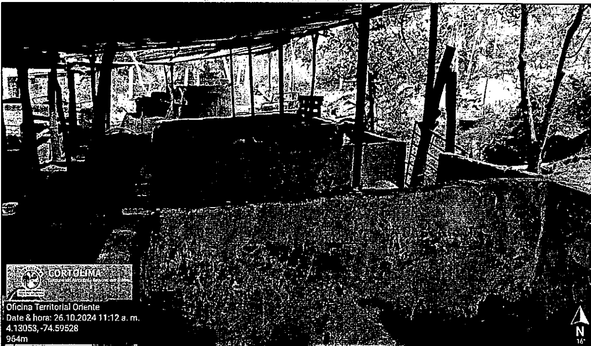
Fotografía No 4. Porquerizas con estructura de 45 m 2 , dividido en dos secciones, con 10 camas de 2x2, techo en zinc y Eternit, piso en cemento, paredes en ladrillo bloque, donde no se encontraron 12 cerdos (10 hembras 2 machos o padrones) y 22 crías de levante, para un total de 34 individuos.
