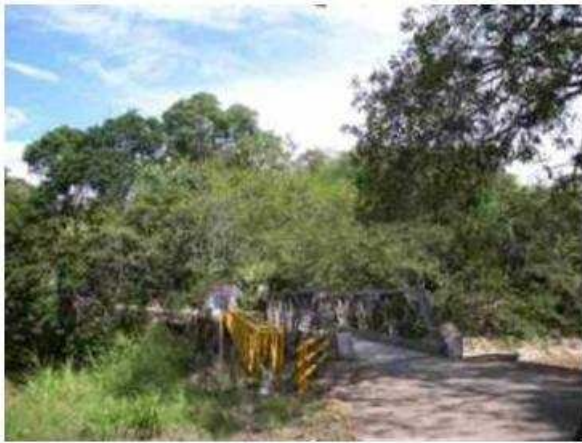
Foto 3-39. Puente sobre el Río Luisa que une las veredas El Dinde y Caracolí
