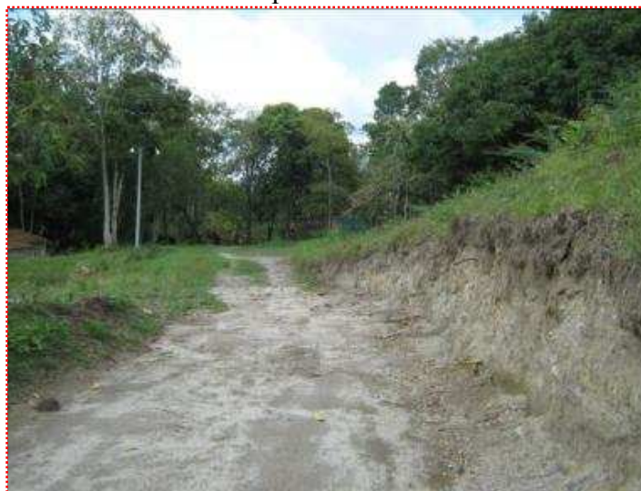
Foto 3-4. Horizonte A de 25 cm de espesor
