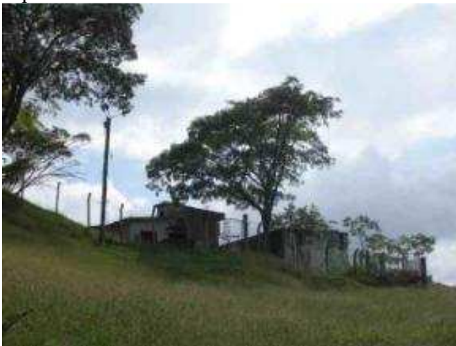
Foto 3-32. Tanques del acueducto-Vereda El Dinde
