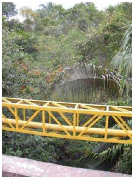
Foto 3-37. Cruce de la tubería del acueducto sobre el Río Luisa
