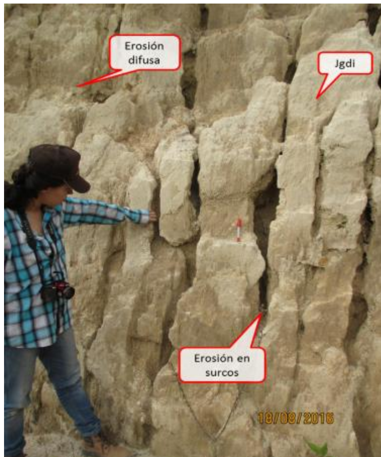
Figura 139. Erosión difusa y en surcos sobre el suelo residual del Batolito de Ibagué al occidente del poblado de Rovira. Coordenadas: E= 860384.770455 N= 963161.454581 Altura: 1939.56 msnm
