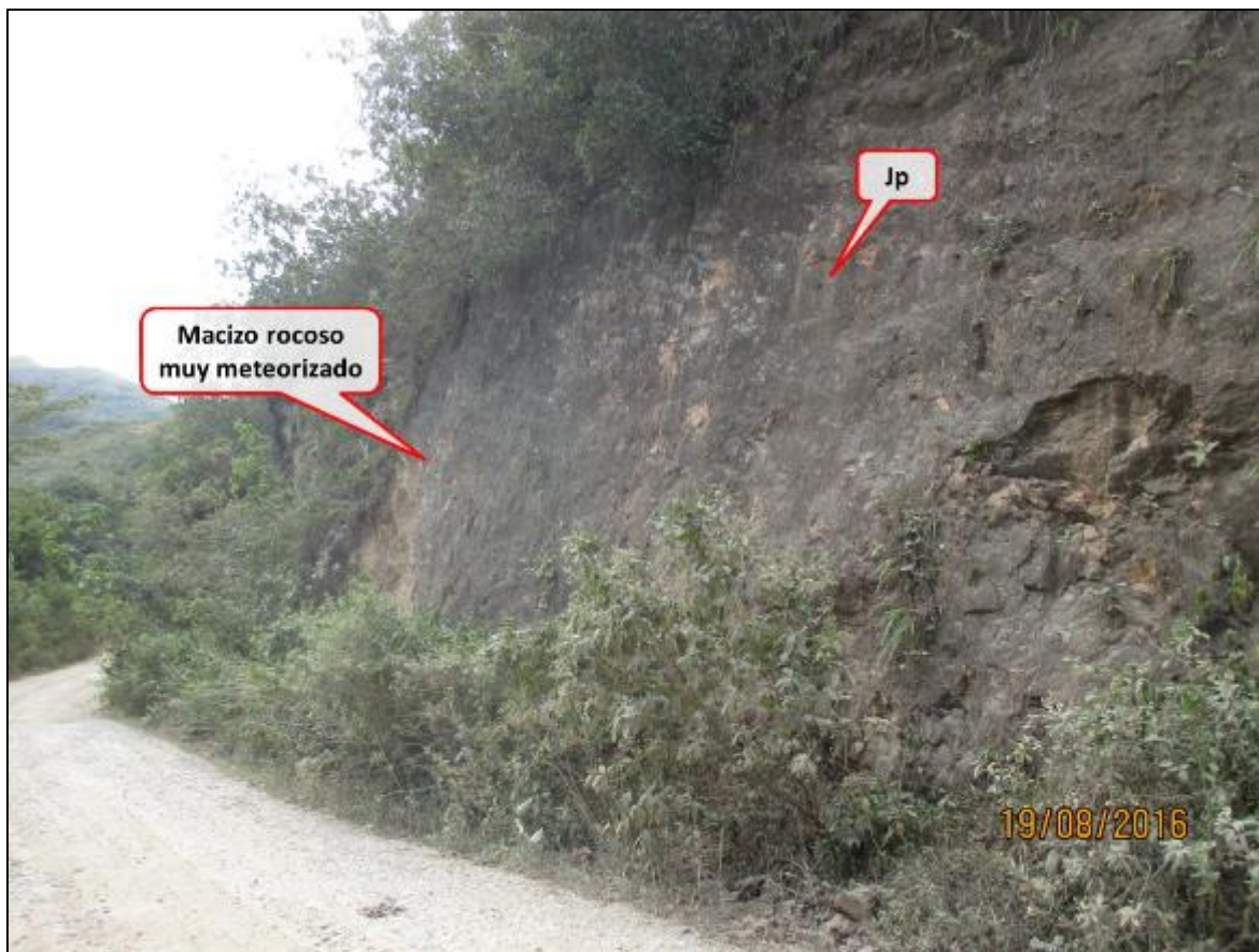
Figura 31. Stock de Payandé (Jp) Aflorando al Occidente del Poblado de Payandé. Coordenadas E= 879097.241153 N= 963822.794833 Altura: 782.62 msnm.
