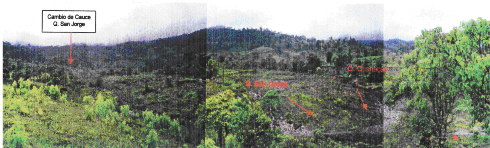
Fotos 2.16, 2.17 y 2.18 Procesos de remoción en masa (amenaza alta), vereda Guanacas municipio de Villarrica - Tolima
