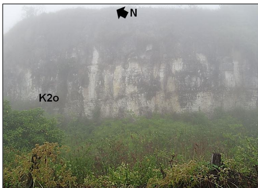
Figura 12. Afloramiento del Grupo Olini (K2o) en la vía que del municipio de Melgar conduce al municipio de Icononzo, sobre la vereda Águila Alta del municipio de Melgar. Fuente: GEOCING S.A.S, 2018
