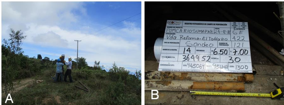
Figura 33. Sondeo 121. A. Trabajadores extrayendo muestra. B. Muestra recuperada a 7 m de profundidad. Fuente: GEOCING S.A.S, 2018
