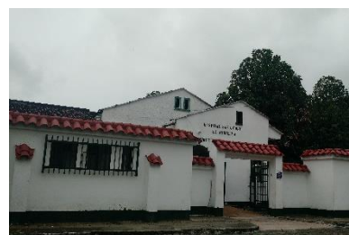
Hospital San Antonio de Ambalema
