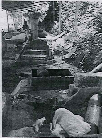
Fotografía 1. Infraestructura preexistente construida por parte de Mineros S.A.
