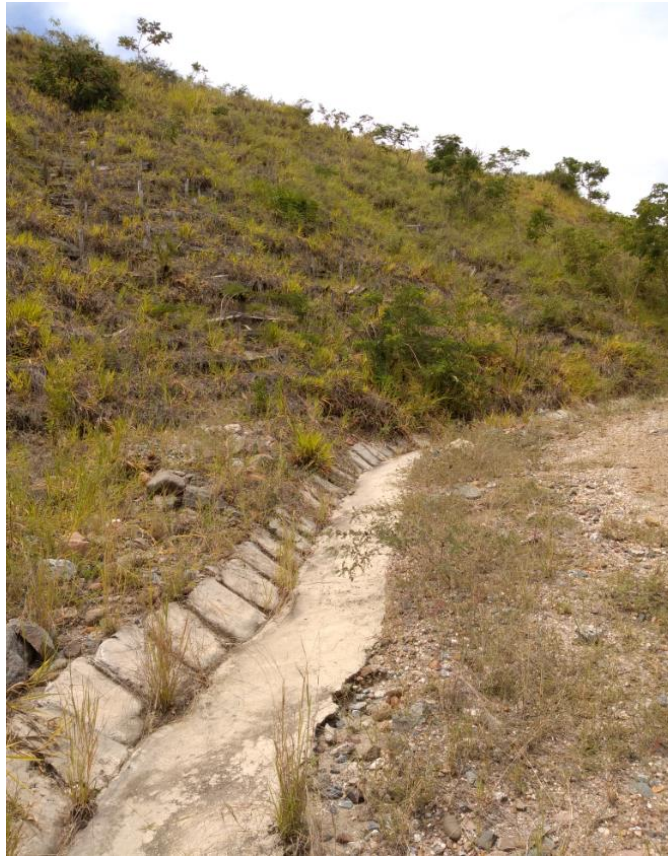
Fotografía 3. Estructuras en concreto construidas sobre el costado norte de la escombrera Superior. Fuente: Elaboración propia
