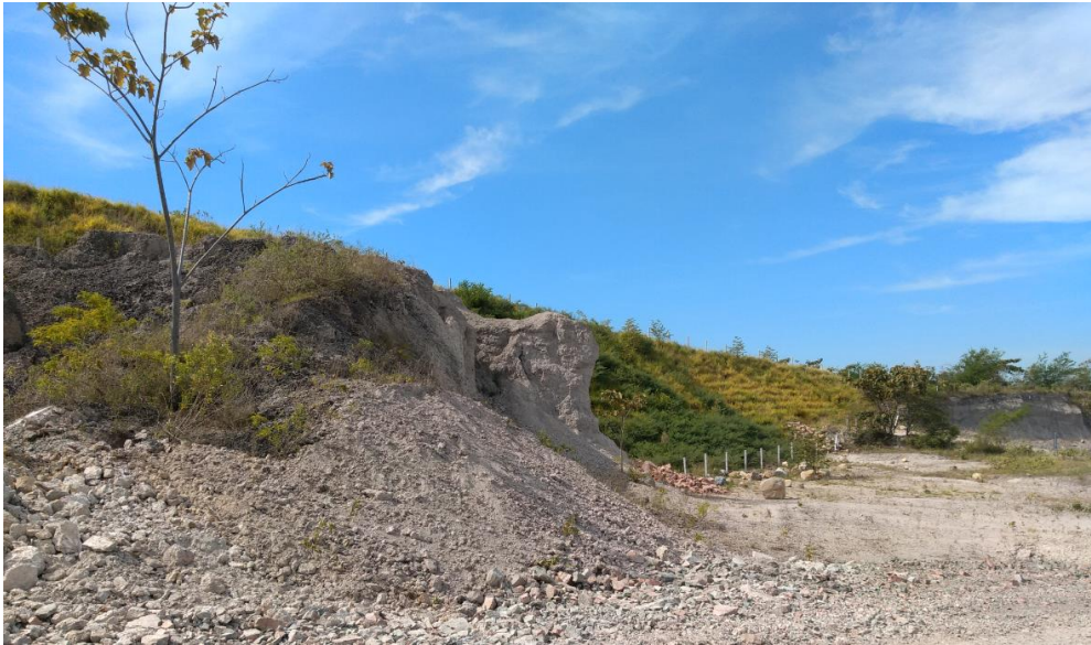
Fotografía 4. Talud sur escombrera Superior revegetalizado Fuente: Elaboración propia
