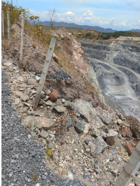
Fotografía 1. Proceso erosivo parte alta de zona de extracción Caliza Fuente: Elaboración propia
