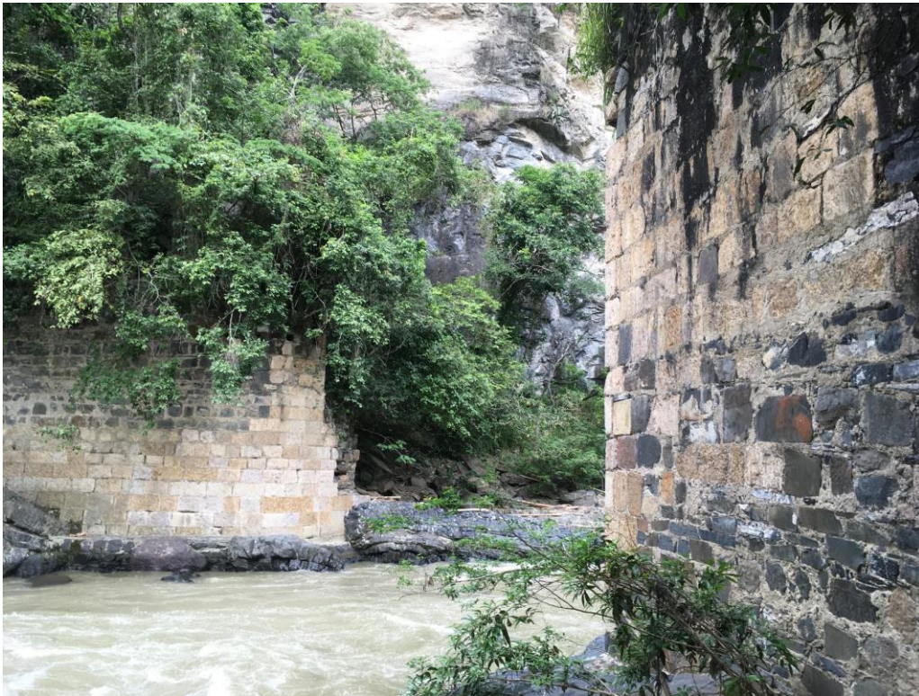
Fotografía 126. Ruinas de Puente Viejo
