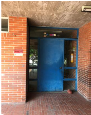
Fotografía 66. Salón Sede Primaria
