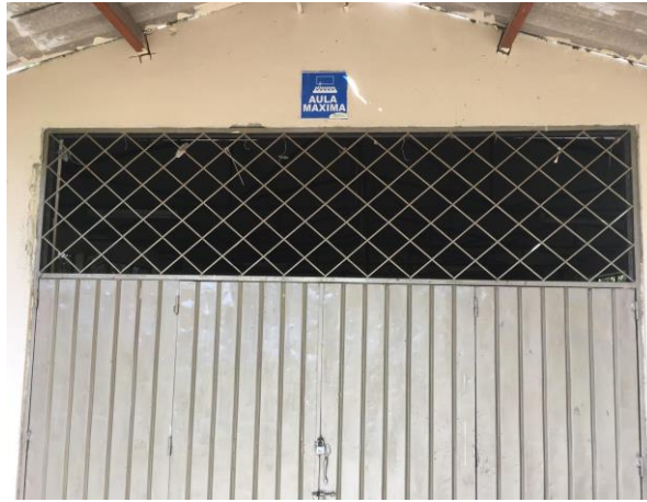
Fotografía 75. Aula Múltiple Sede Bachillerato
