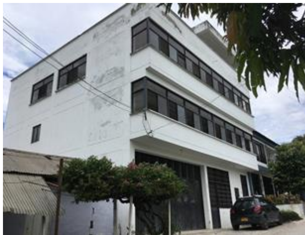
Fotografía 91. Edificio construido por CEMEX
