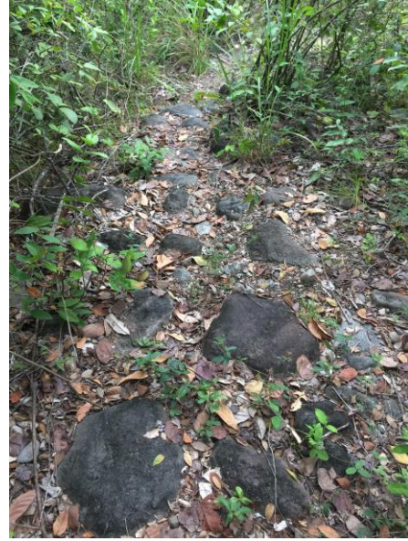
Fotografía 125. Posible camino real
