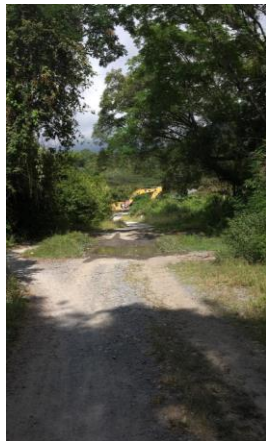
Fotografía 99. Maquina atravesando el cruce
