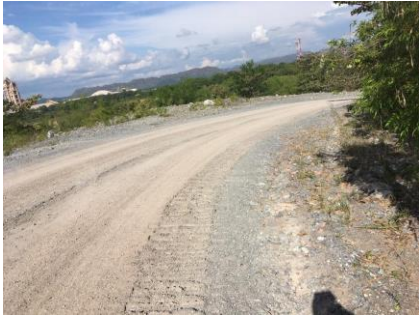
Fotografía 101. Vía por donde transita maquinaria pesada de CEMEX y los pobladores de Payandé
