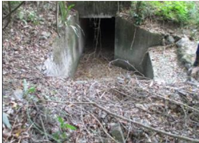
Figura 103. Registro Fotográfico – FQ 6 DRENAJE EL SALADO Temporada seca
