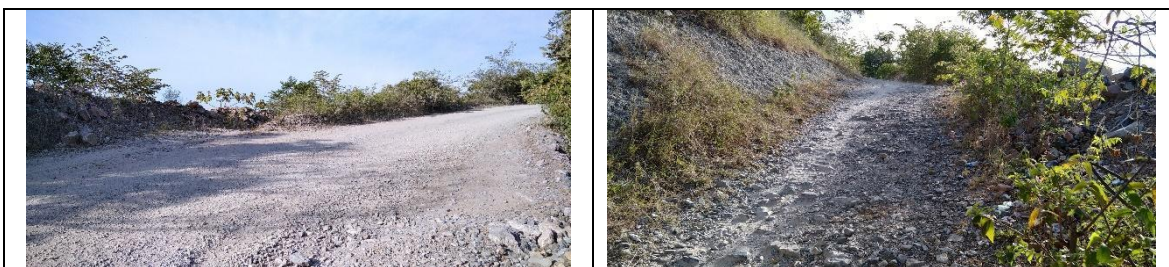
Fotografía 96. Vía 1 punto 1b Entrada Mina Payandé Fuente: Elaboración propia
