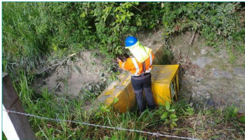
Fotografía 81. Estación DSAGAR, ubicada aguas arriba del Drenaje El Salado.
