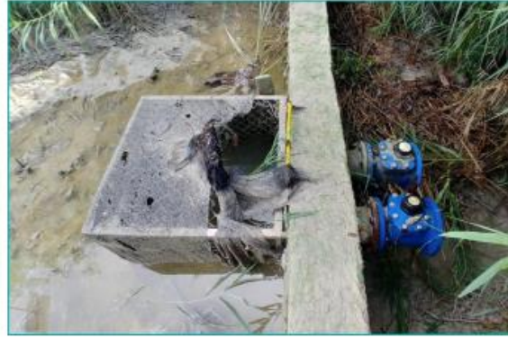
Fotografía 82. Estación SSD en el Sistema de Salida de Descarga de agua del Pit Calizas. Izquierda: Sedimentador Descarga de Agua. Derecha: Caudalímetros donde se vierte agua del Pit Calizas hacia el Drenaje El Salado, durante el monitoreo el agua rebosó la poza de sedimentación. Fuente: WES Perú SAC, 2020.
