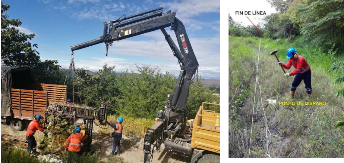
Fotografía 91. Labores de exploración geotécnica área de influencia Mina Esmeralda.
