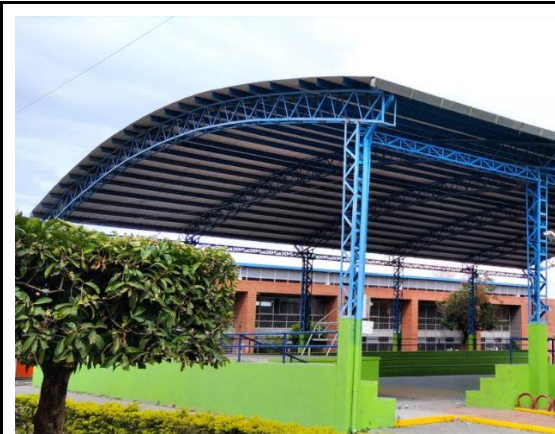
Fotografía 102. Coliseo Payandé Fuente: Elaboración propia
