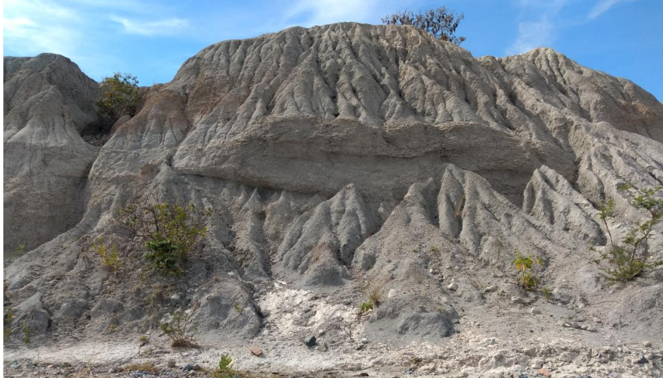
Fotografía 93. Procesos erosivos talud caliche, al costado noroeste de la escombrera superior. Fuente: Elaboración propia
