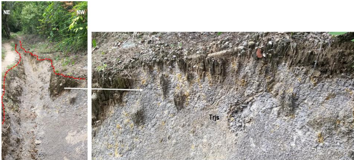
Fotografía 33. Generación de cárcava de erosión afectando suelos y rocas de la Formación Saldaña (Trjs), PM6, asociada a arcillolitas, PM3, título minero 745 mina La Esmeralda. Coord. Este 4 766 343; Coord. Norte 2 033 866 Fuente: Elaboración propia.
