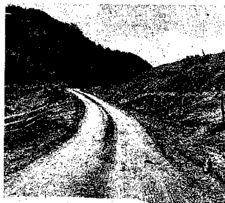
Imagen 2. Vías internas Relleno Sanitario La Miel
