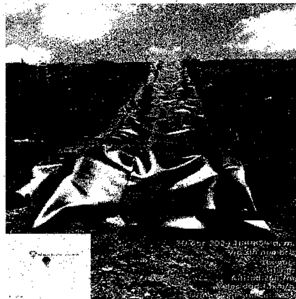
Ilustraciones 8 y 9. Construcción de bajantes talud vaso D2-PIRS La Miel. Fuente: Autor.
