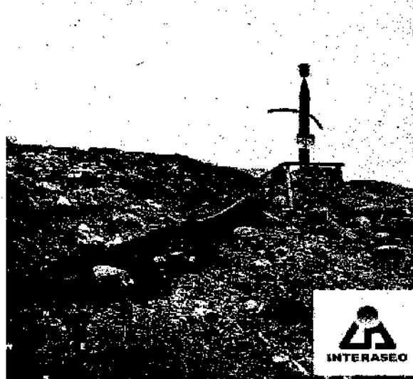
Ilustración 7. Construcción de filtro sobre talud vaso D2-PIRS La Miel. Fuente: Autor.
