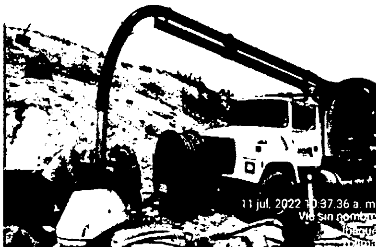
Ilustración 6. Limpieza con equipo vector. Fuente: autor.
