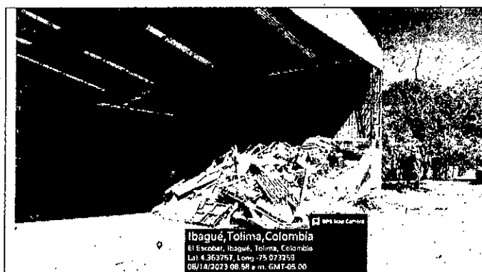
Foto 1. Zona de acopio y recepción de residuos sólidos
