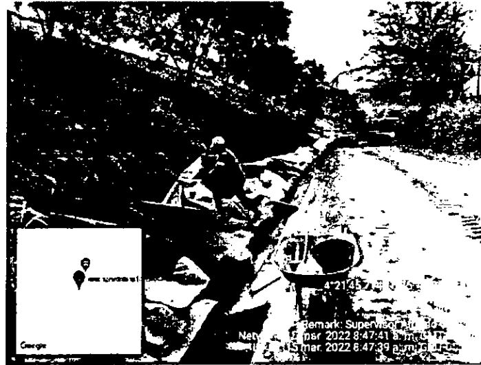
Imagen 20. Cubrimiento de filtro, PIRS La Miel. Fuente: autor.
