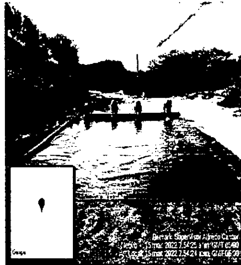
Imagen 18. Extensión de geomembrana para cubrimiento de filtros, PIRS La Miel. Fuente: autor.
