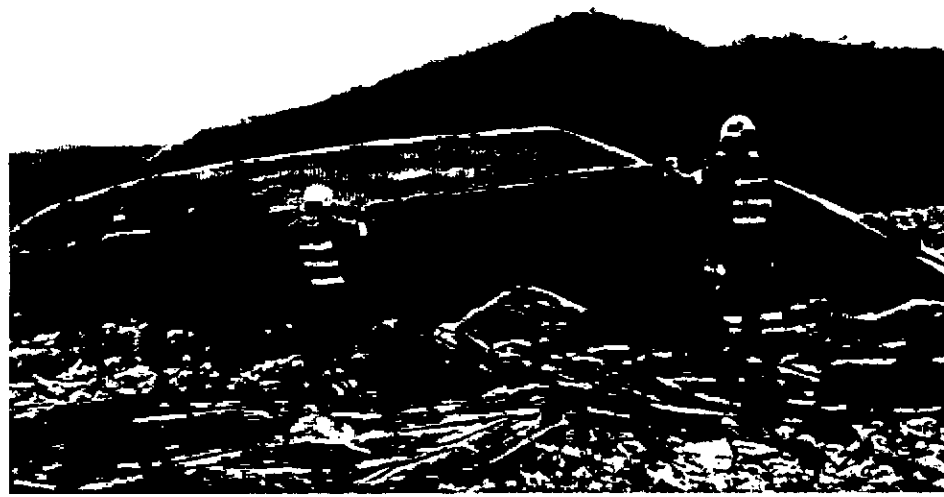
Imagen 6. Cubrimiento de residuos con manto negro-verde, PIRS La Miel. Fuente: autor.
