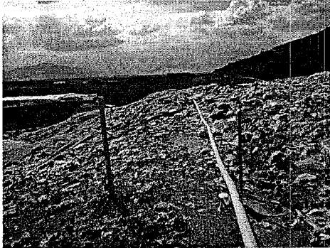
Se aprecia la tubería con la cual se hace recirculación de los lixiviados a la celda
