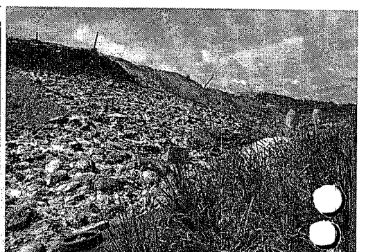
Zona inferior de la celda D1 con material terreo, residuos expuestos y la adecuación del filtro en llantas
