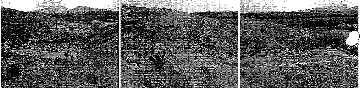
Estado de la zona D y C con cobertura terrea y sintética de los residuos sólidos
