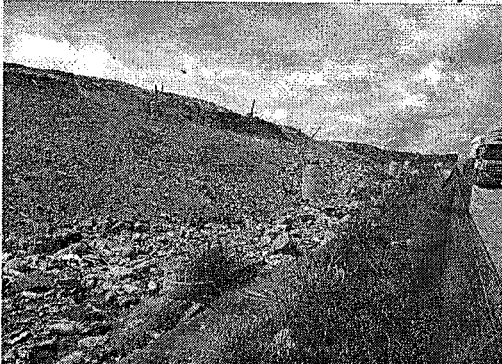
Se observa la adecuación de la berma en la zona D, se aprecia la adecuación de los filtros
