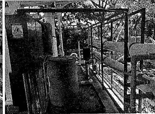
unidades de tratamiento del lixiviado hasta la osmosis inversa la cual no se encontraba operando
