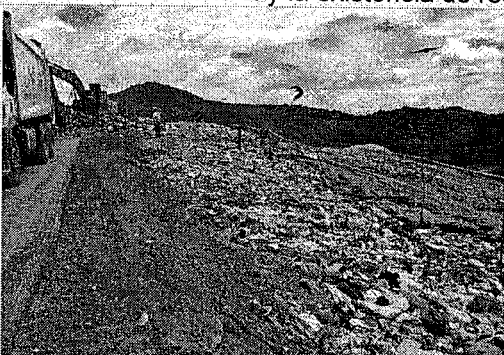
Zona de celda con residuos cubiertos con material sintético sin adecuada conformación de la masa de residuos
