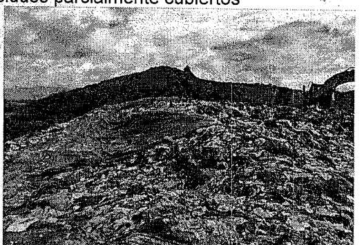
Zona de celda con residuos cubiertos con material sintético sin adecuada conformación de la masa de residuos
