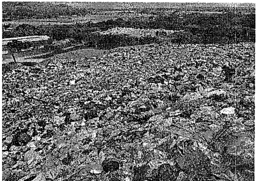
Se aprecian los residuos sin cubrimiento, se observa la retroexcavadora en proceso de conformación de los residuos
