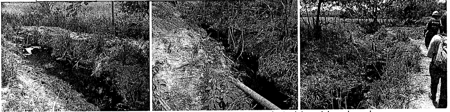
Continuación del recorrido observando el comportamiento del caudal en el canal
