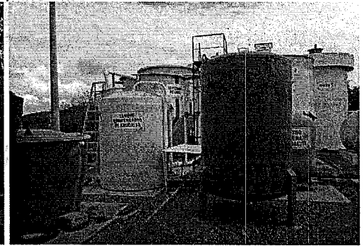
Estado del sistema de tratamiento, se aprecian los reactores anaerobios, los clarificadores y las unidades de filtración
