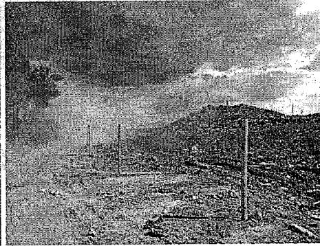
Zona de la celda con vía sin humectación, se aprecia la resuspensión de material particulado y la zona de residuos expuestos
