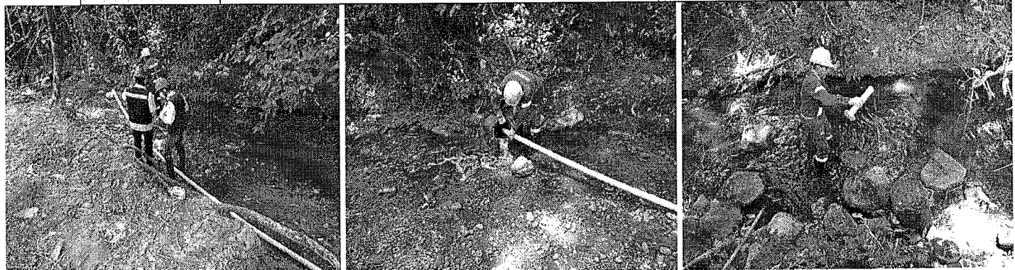
Sitio de descarga de los lixiviados a la fuente hídrica, se aprecia la zona de mezcla en los 100 metros iniciales
