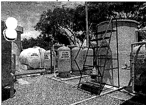
unidades de tratamiento del lixiviado hasta la osmosis inversa la cual no se encontraba operando
