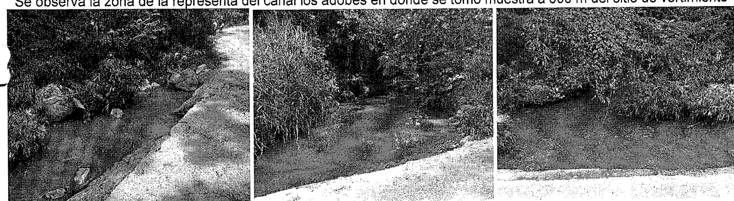
Paso del agua del canal en la vía interna de la hacienda el aceituno en regulares condiciones de calidad
