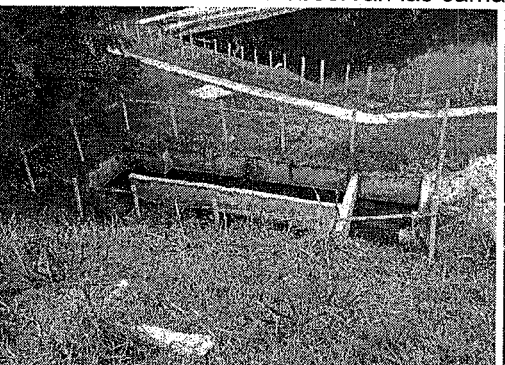
Se aprecia las unidades de pretratamiento, la laguna de oxidación 1 con el refuerzo de su dique perimetral
