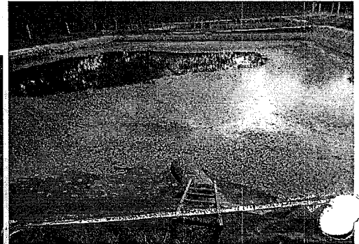
Inadecuada disposición de los residuos de poda, se aprecian procesos erosivos en la cobertura y el paso de la tubería para recircular el lixiviado
