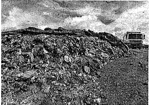
Zona de celda con residuos cubiertos con material sintético sin adecuada conformación de la masa de residuos
