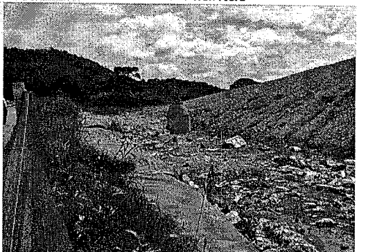
Se observa la adecuación de la berma en la zona D, se aprecia la adecuación de los filtros
