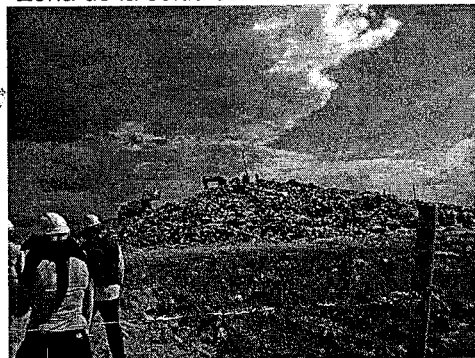
Zona de celda diaria con area mayor al area autorizada, sin el respectivo cubrimiento
