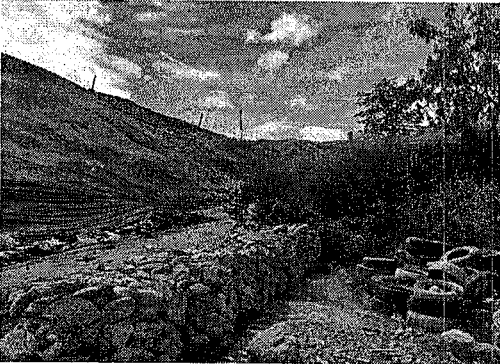
Zona inferior de la celda D1 con material terreo, residuos expuestos y la adecuación del filtro en llantas
