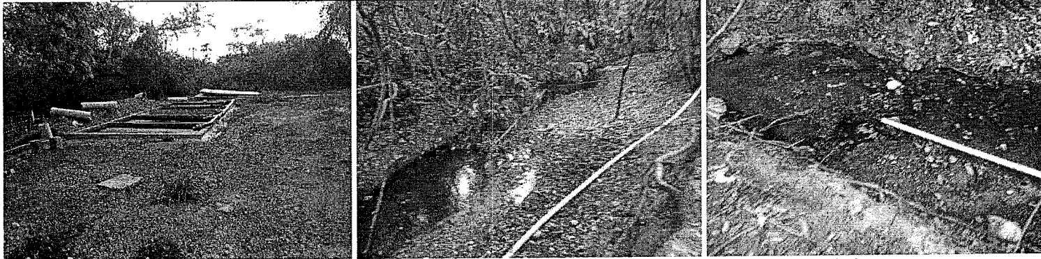
Unidad de secado de lotes y zona de vertimiento del lixiviado tratado antes del vertimiento
