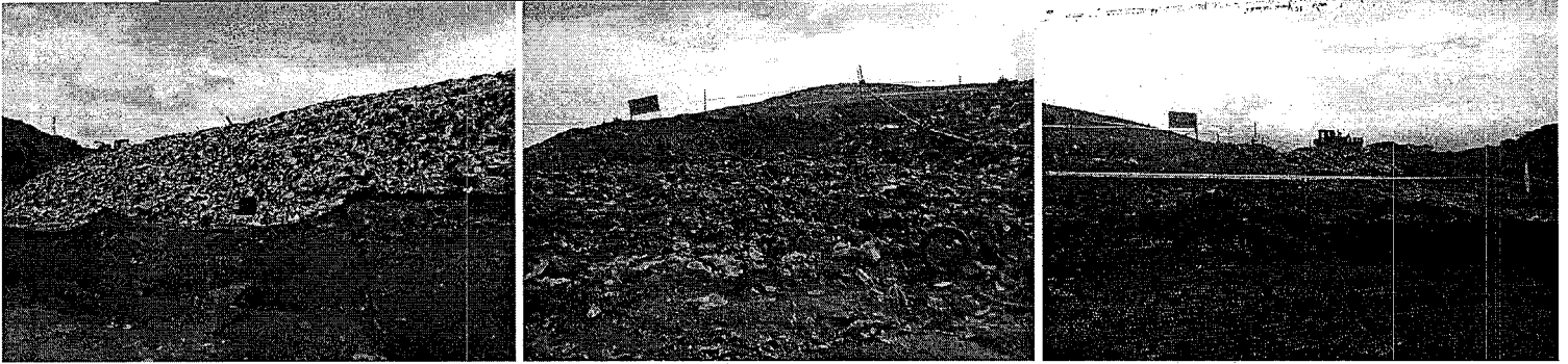
Estado de los residuos sólidos dispuestos sin cobertura, parcialmente cubiertos con material terreo
