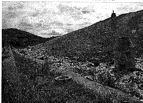
Zona inferior de la celda D1 con material terreo, residuos expuestos y la adecuación del filtro en llantas
