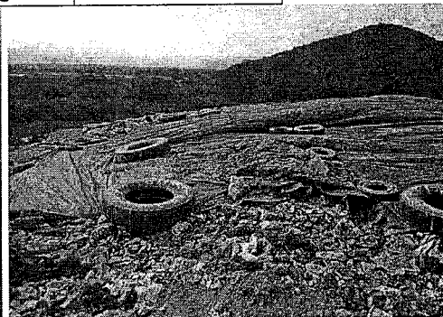
Estado actual de cubrimiento de la zona D con material sintético sin la debida compactación y reconformación
