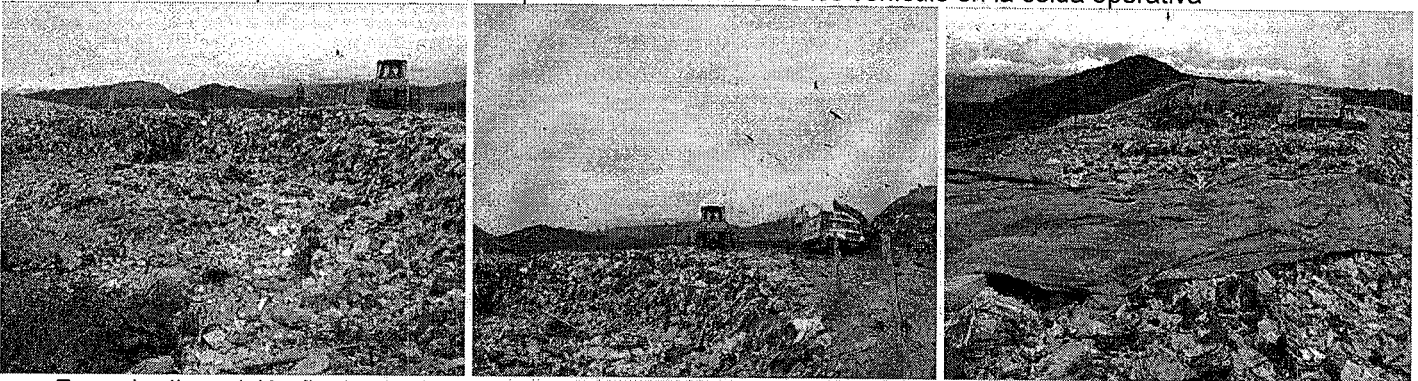
Zona de disposición final actual en proceso de compactación, se aprecia la cobertura sintética de los residuos
