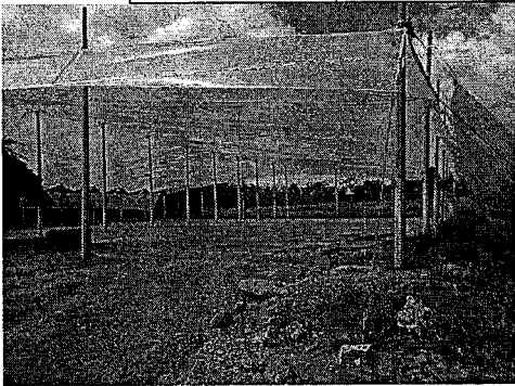
Arreglo de la cubierta y zona D del relleno sanitario, se aprecia la cobertura temporal de los residuos sólidos
