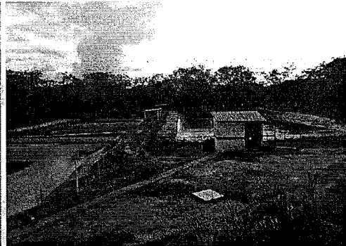
Sistema de tratamiento del lixiviados con sus unidades preliminares
