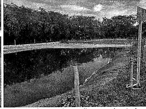
Se aprecia las unidades de pretratamiento con sedimentos, la laguna de oxidación 1 con el refuerzo de su dique perimetral y entrada inundada
