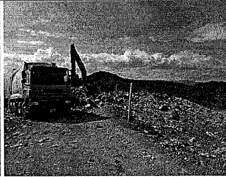
Se aprecia la resuspensión del material particulado y la zona de descarga de los residuos sin adecuado cubrimiento
