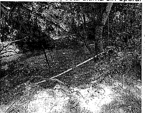
Se aprecia el lecho de secado de lodos de los reactores y la tubería de los lixiviados tratados hacia la fuente hídrica
