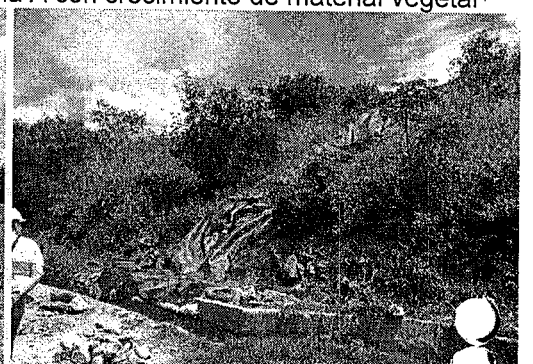
Se aprecian filtraciones del lixiviado en las cunetas de aguas lluvias y el estado de las obras de manejo de aguas lluvias
