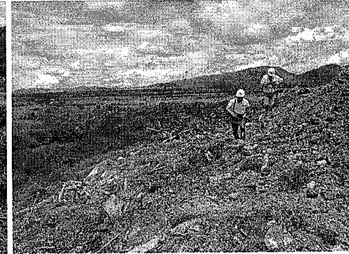
Se destaca que dicho material no se está bio-transformando, solo se empuja al talud sin mantener condiciones de estabilidad
