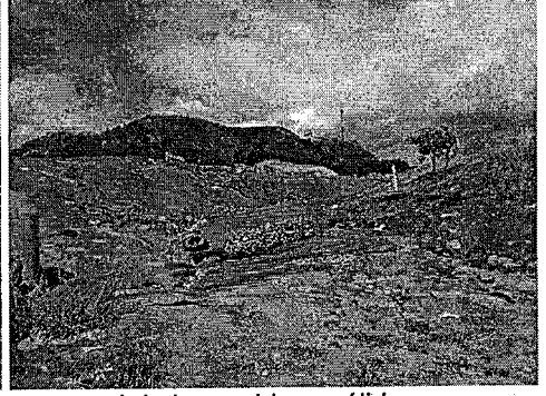
Arreglo de la cubierta y zona D del relleno sanitario, se aprecia la cobertura temporal de los residuos sólidos
