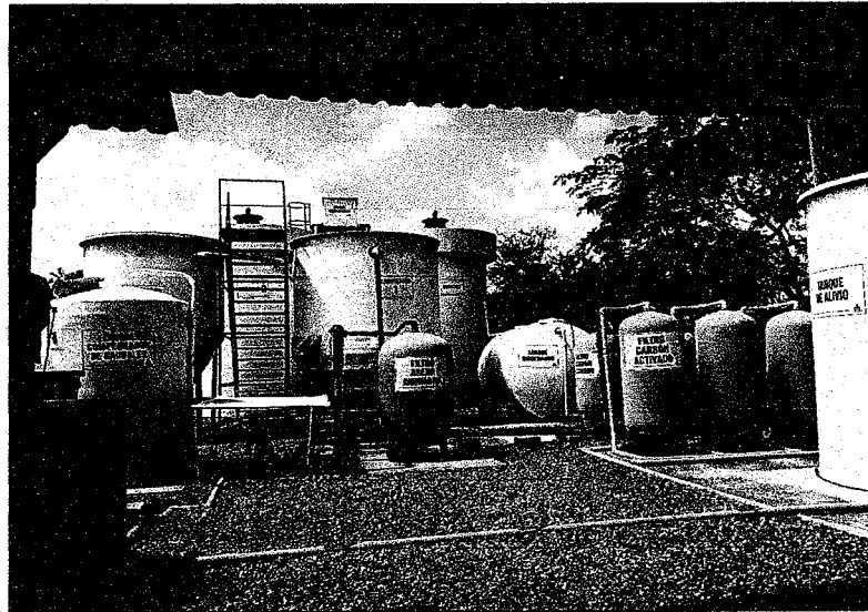
Foto 8. Planta de tratamiento de agua residual – Relleno La Miel.
