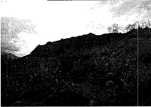
Inadecuada disposición de los residuos de poda, se aprecian procesos erosivos en la cobertura y el paso de la tubería para recircular el lixiviado
