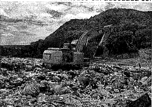
Se aprecian los residuos sin cubrimiento, se observa la retroexcavadora en proceso de conformación de los residuos
