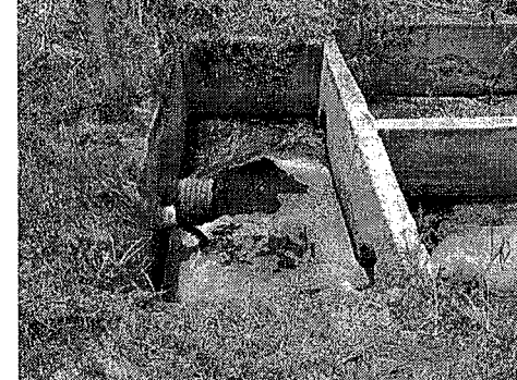
Sistema de pretratamiento existente sin contar con mecanismos para retener grasas o material grueso, se aprecia la primera laguna de tratamiento
