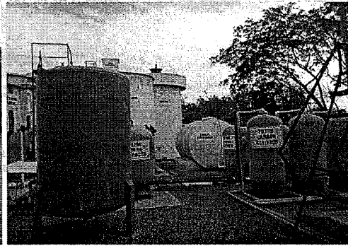
Estado del sistema de tratamiento, se aprecian los reactores anaerobios, los clarificadores y las unidades de filtración
