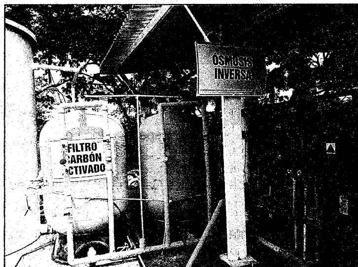
Foto 9. Filtro carbón activado (baterías) y Osmosis inversa
