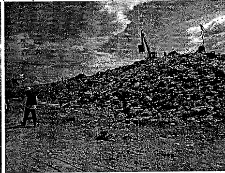
Zona de celda diaria con area mayor al area autorizada, sin el respectivo cubrimiento
