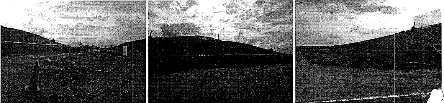
Adecuación de la celda D con los residuos cubiertos con tierra
