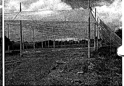
Se observa el retiro de las mangueras de conducción del lixiviado y la reparación de la cubierta del area de biotecnología con el plástico tipo invernadero
