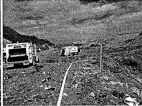
Se aprecia la tubería con la cual se hace recirculación de los lixiviados a la celda
