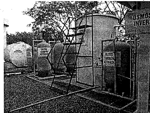
Unidades de filtración, unidad de tratamiento avanzado sin operación y zona de acopio y preparación de insumos
