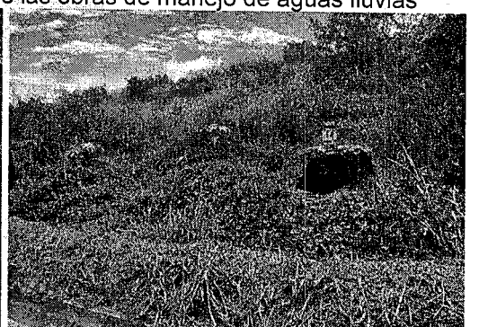
Se observan las cámaras de infiltración de lixiviados y el estado de la cobertura vegetal
