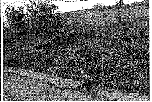
Inadecuada disposición de los residuos de poda, se aprecian procesos erosivos en la cobertura y el paso de la tubería para recircular el lixiviado
