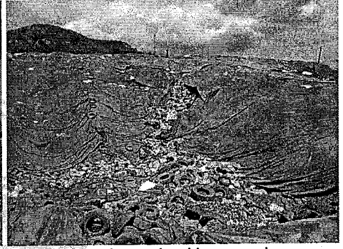
Se observa la impermeabilización del vaso con la inadecuada conformación de los residuos ocasionando el ingreso de aguas lluvias en su interior
