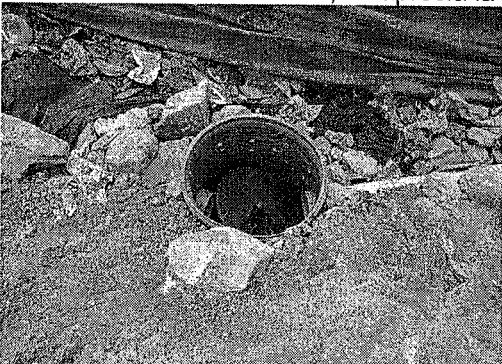
Se aprecia la adecuación de los filtros con sus cajas de entrega y el panorama general del sitio con cobertura terrea y sintética
