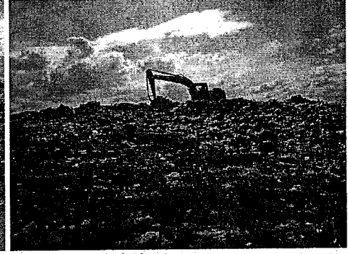
Zona de celda diaria con area mayor al area autorizada, sin el respectivo cubrimiento
