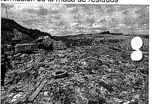
Se aprecian los residuos sin cubrimiento, se observa la retroexcavadora en proceso de conformación de los residuos
