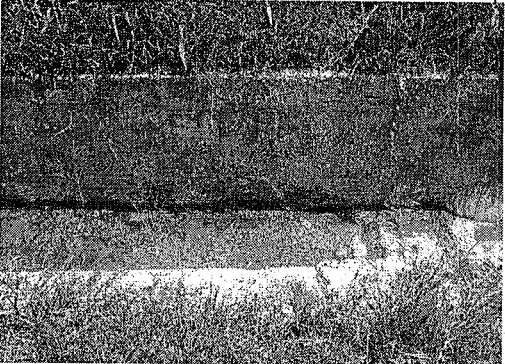
Se aprecian filtraciones del lixiviado en las cunetas de aguas lluvias y el estado de las obras de manejo de aguas lluvias
