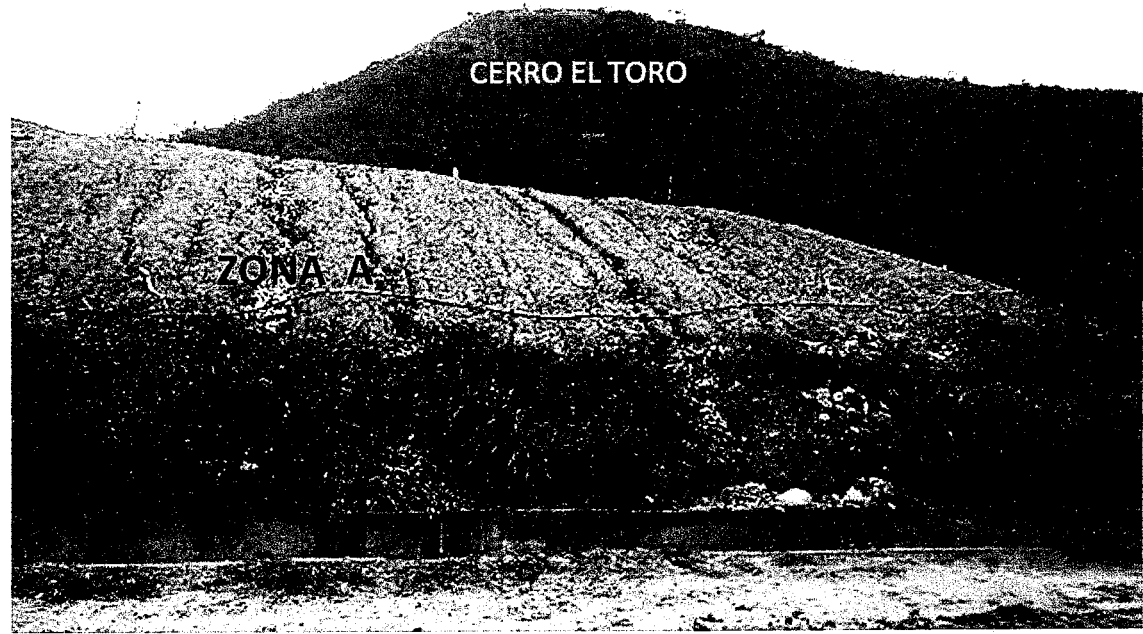
FIGURA 7. Huellas de erosión en surco y cárcavas del talud de la Zona A (vista al norte)
