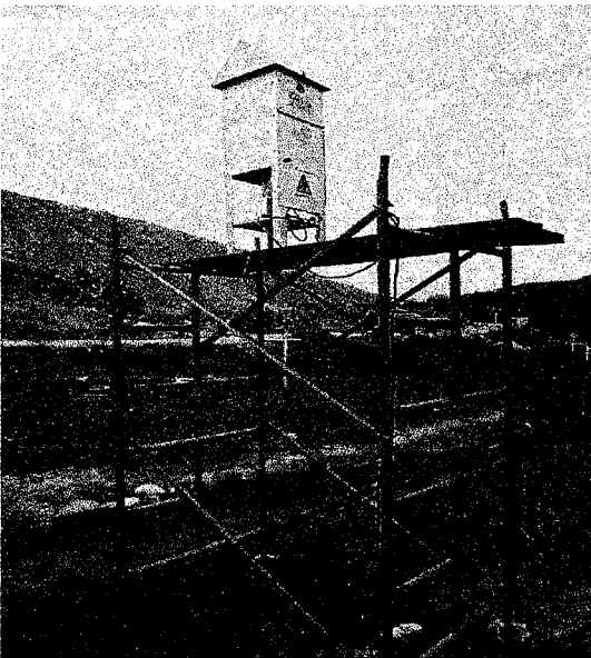
FOTO 3. UBICACIÓN EQUIPO KPST-3 "TANQUES"
