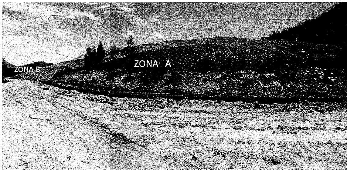
FIGURA 4. Estado actual de la Zona B correspondiente al talud situado en el extremo oriental del relleno sanitario (vista hacia el occidente).
