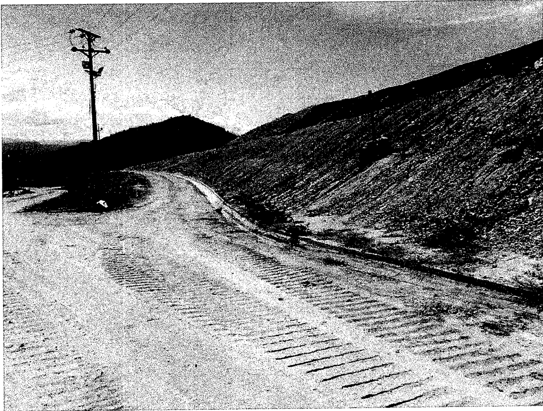
FIGURA 2. Talud del sector central de la Zona C (vista al noroeste)
