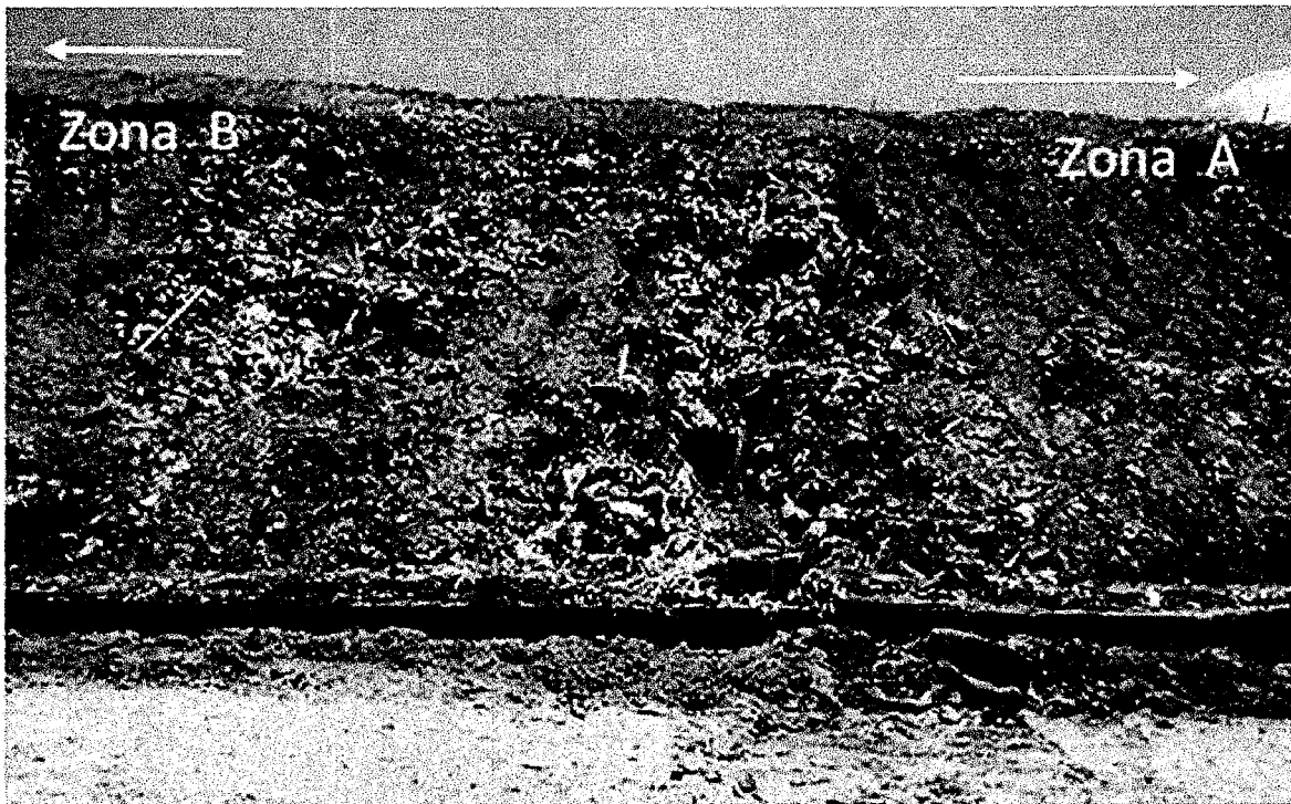
Figura 5. Sector de transición entre la Zona A y la Zona B (Talud visto al norte)
