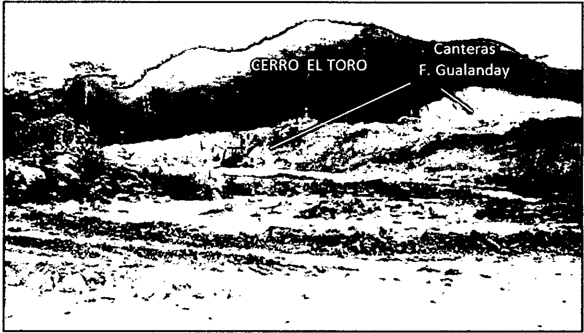
Figura 1. Zona y labores de extracción del material de cobertura (vista hacia el norte)
