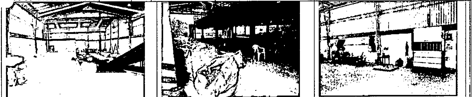
Instalaciones internas de la planta de separación se aprecian los equipos de valor agregado
