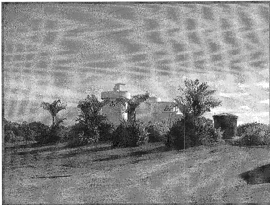
Foto 3. Tanques tratamiento de lixiviados.
