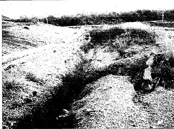
FOTO 8. Costado oeste del relleno, canal interceptor de aguas de escorrentía superficial externa al relleno, en tierra. El canal presenta corona erosionada.
