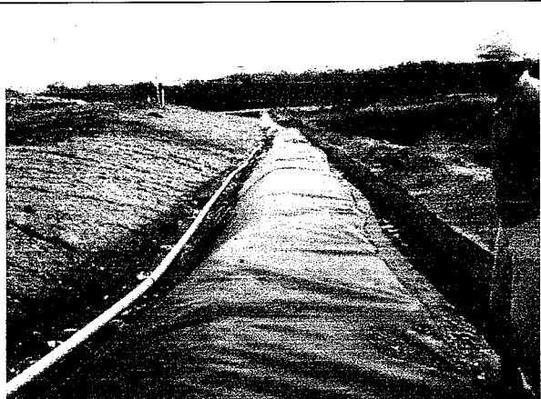
FOTO 7. Detalle del costado oeste del relleno en proceso de conformación. Se observan estructuras de drenaje subsuperficial (tubería) y superficial (canal de evacuación revestido en concreto).
