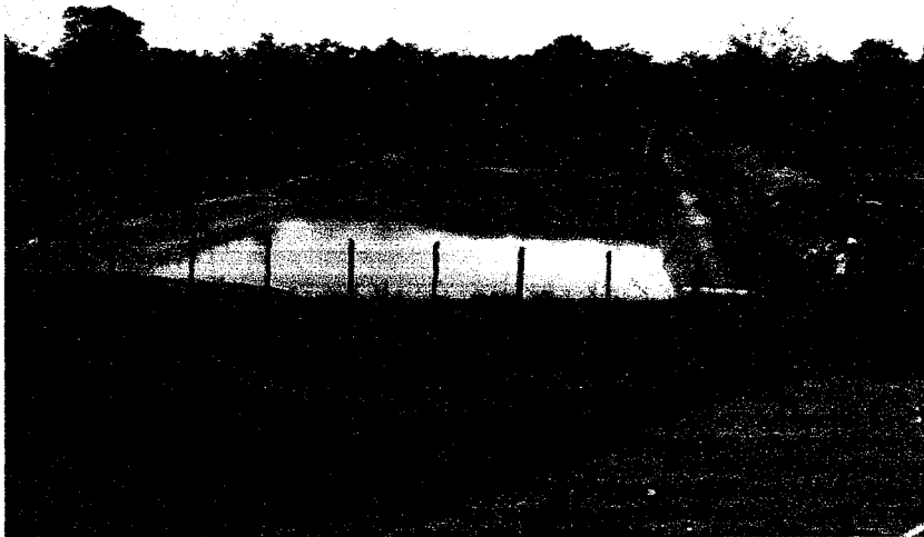
Fotografía #22 Lagunas para almacenamiento de lixiviados. Relleno sanitario La Miel Ibagué Abril 26 de 2006
