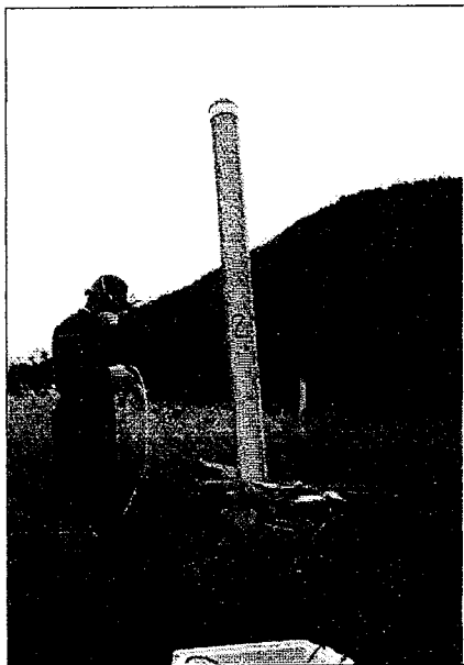
Fotografía No.1 Chimeneas Relleno Sanitario La Miel. Detalle de la considerable Altura
