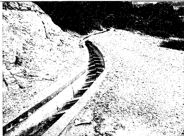
FOTO 11. Canal en concreto con estructuras de disipación, opera como interceptor de aguas de escorrentía superficial. Se observa fisura e inicio de erosión superficial cerca del canal.
