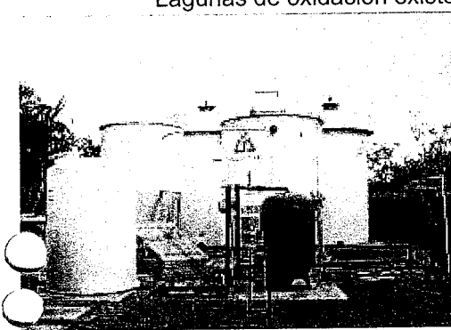
Sistema de tratamiento de lixiviados se aprecian los reactores, coaguladores, filtros y la planta de osmosis inversa.
