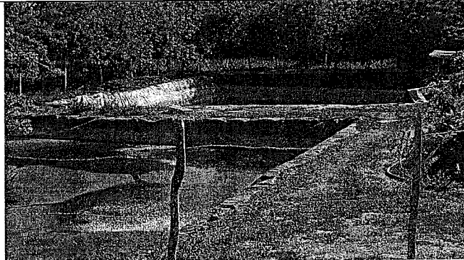
Foto 3. Piscinas de tratamiento de lixiviados.
