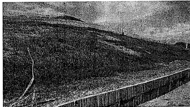
Foto 4. En la fotografía se observa la cuneta perimetral para el control de aguas de escorrentía. Se observan los taludes parcialmente vegetalizados.
