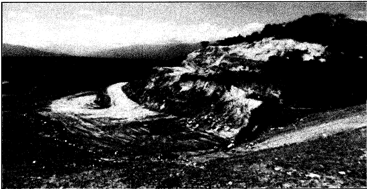
FIGURA 3. Explotación por bancos de material de cobertura y adecuación del terreno para futura celda de disposición de residuos sólidos
