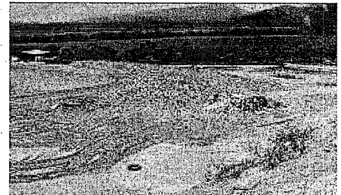
Estado de la celda actual, se aprecian las chimeneas de venteo, se observa el estado de la cuneta perimetral y la limpieza de volátiles, se destaca la existencia de celda de contingencia.
