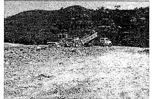
Estado de los residuos en la celda, se aprecia la existencia de cobertura y la actividad del Bogmar para la compactación de los residuos
