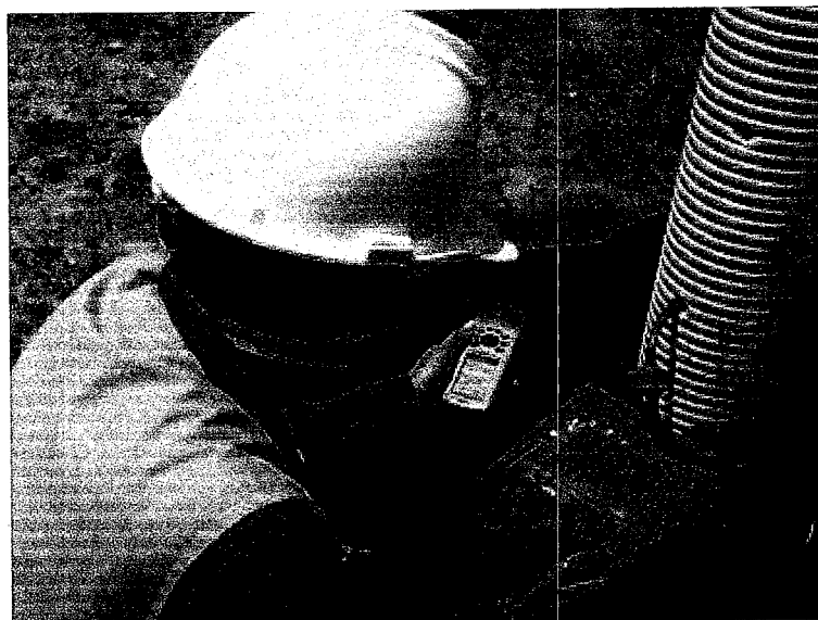
Fotografía 4. Toma Lectura y Georreferenciación en Chimenea de la Zona A.
