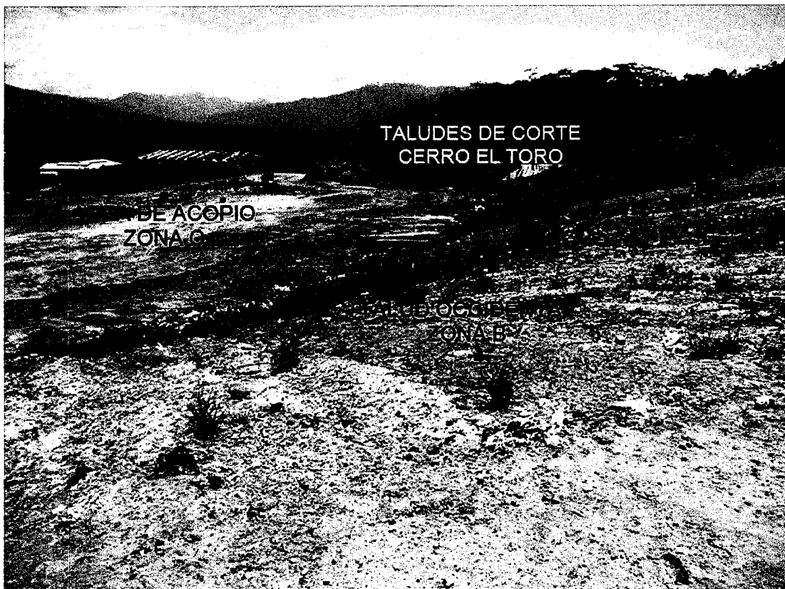
FIGURA 2. Condición de estabilidad por remoción en masa de los taludes adyacentes a la zona C (vista sureste a noroeste, desde la zona B hacia la Zona C)
