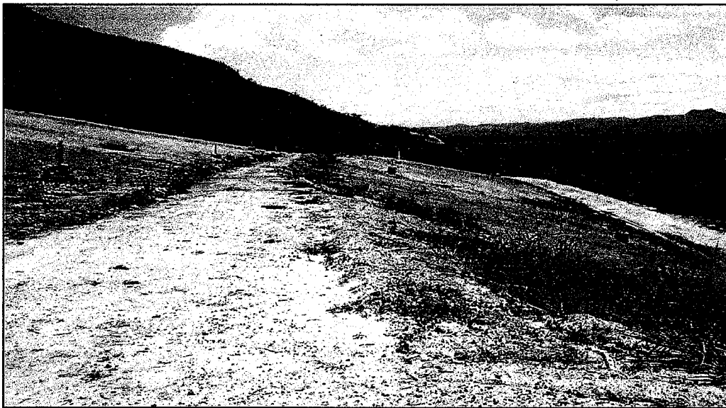
FIGURA 3. Estado de re conformación de los taludes sur de las zonas A y B.
