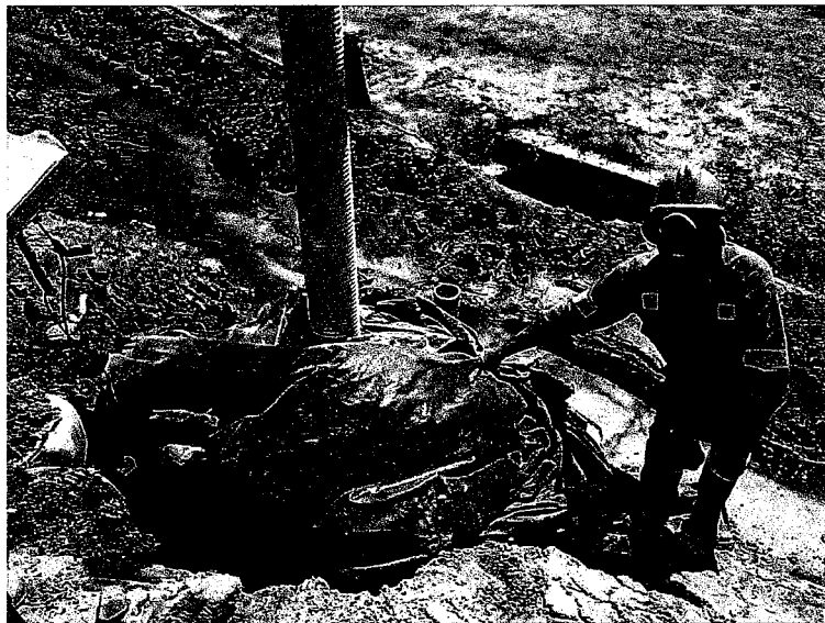
Fotografía 2 Chimenea Debidamente Cubierta
