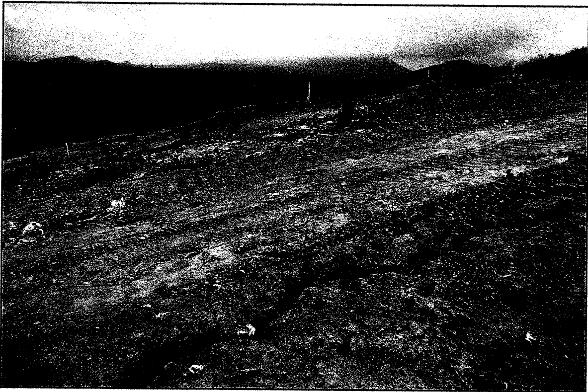
FIGURA 3. Estado del talud sur de las zonas A (parte cercana) y B (al fondo de la foto); vista de oriente a occidente.
