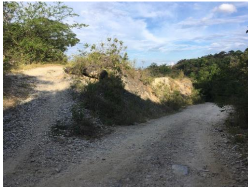
Fotografía 5. Punto de conexión del camino veredal (izquierda) con la carretera de acceso a Payandé (derecha)
