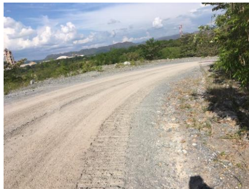
Fotografía 3. Tramo de la vía por donde transita maquinaria pesada de CEMEX y comunidad usuaria
