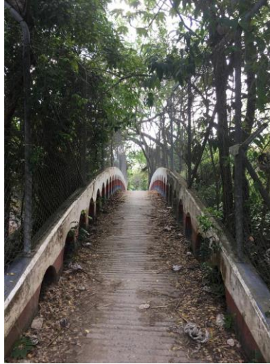
Fotografía 2. Puente Mular acceso a camino de uso comunitario
