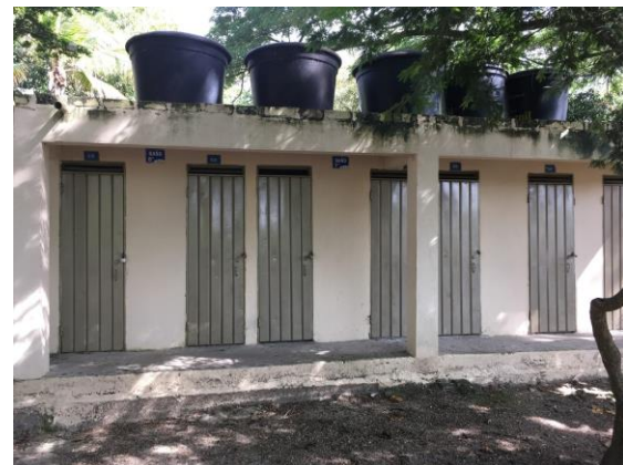
Fotografía 74. Baños Sede Bachillerato
