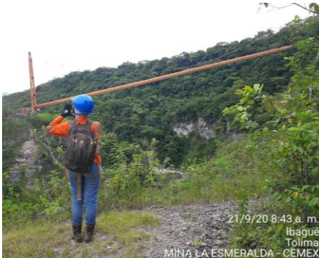
Fotografía 128. Banda Mina de CEMEX Colombia S.A
