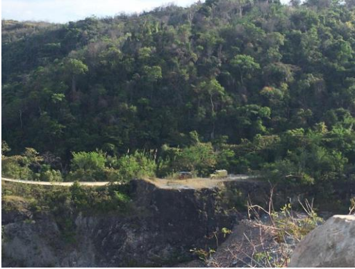
Fotografía 103. Vista a la vía Soplamicos.
