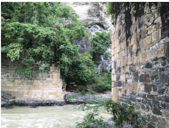
Fotografía 112. Estructuras Puente Viejo a las orillas del río Coello
