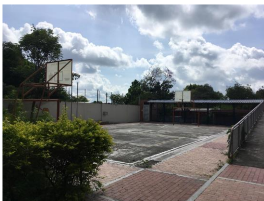
Fotografía 68. Instalación deportiva Sede Primaria
