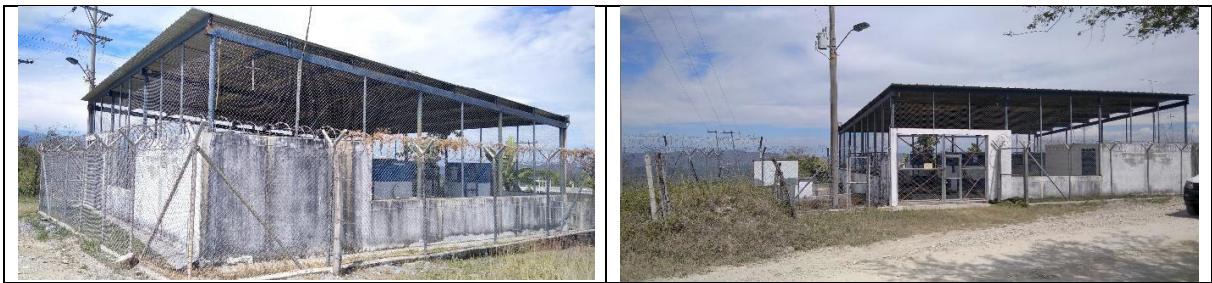
Fotografía 87. PTAP del corregimiento de Payandé Fuente: Elaboración propia
