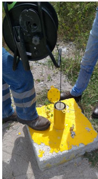
Fotografía 96. Medición del piezómetro PZ-05 sector pit sur mina La Esmeralda.
