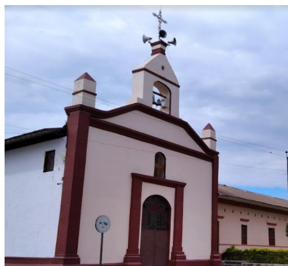
Fotografía 132. Iglesia Santa Bárbara - Payandé
