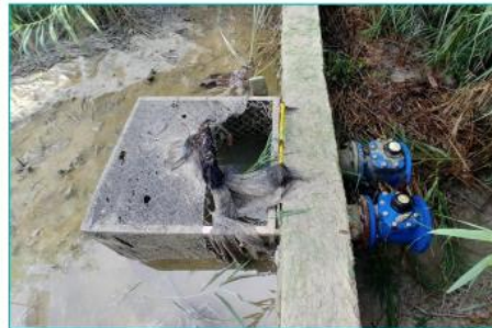
Fotografía 107. Estación SSD en el Sistema de Salida de Descarga de agua del Pit Calizas. Izquierda: Sedimentador Descarga de Agua. Derecha: Caudalímetros donde se vierte agua del Pit Calizas hacia el Drenaje El Salado, durante el monitoreo el agua rebosó la poza de sedimentación. Fuente: WES Perú SAC, 2020.
