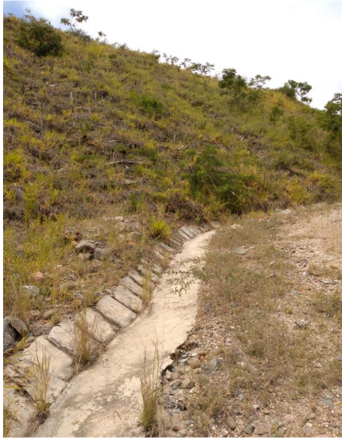
Fotografía 122. Estructuras en concreto construidas sobre el costado norte de la escombrera Superior. Fuente: Elaboración propia
