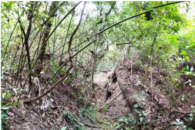
Fotografía 92. Drenaje 1 Fuente: Elaboración propia
