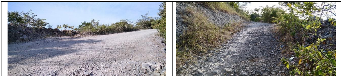
Fotografía 127. Vía 1 punto 1b Entrada Mina Payandé Fuente: Elaboración propia
