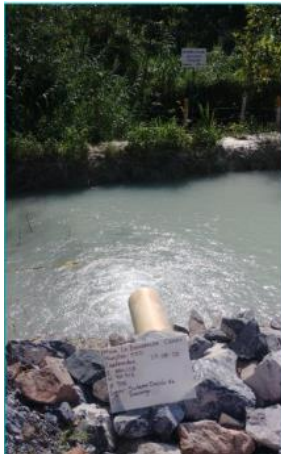
Fotografía 107. Estación SSD en el Sistema de Salida de Descarga de agua del Pit Calizas. Izquierda: Sedimentador Descarga de Agua. Derecha: Caudalímetros donde se vierte agua del Pit Calizas hacia el Drenaje El Salado, durante el monitoreo el agua rebosó la poza de sedimentación. Fuente: WES Perú SAC, 2020.
