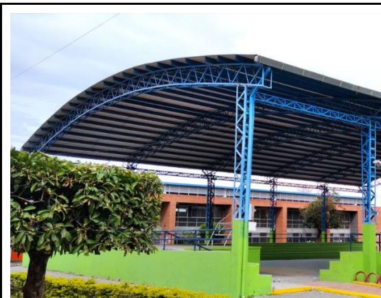
Fotografía 133. Coliseo Payandé Fuente: Elaboración propia
