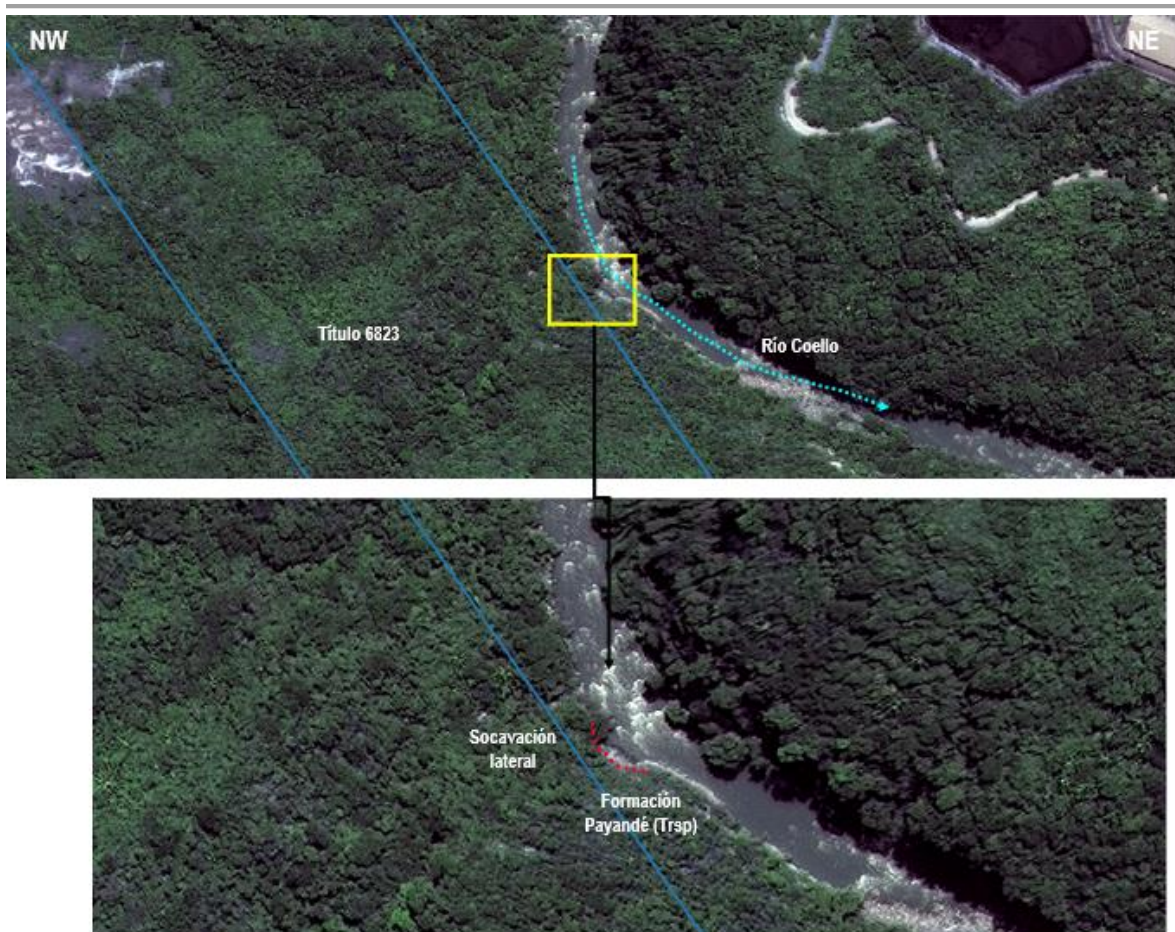
Fotografía 54. Análisis de la ortofoto de 2018 a escala 1:1200, (PM9); se presenta erosión fluvial por socavación lateral margen derecha del río Coello, en morfologías inclinadas asociadas a las rocas calcáreas de la Formación Payandé (Trsp). Coord. Este 4 766 606; Coord. Norte 2 034 115.
