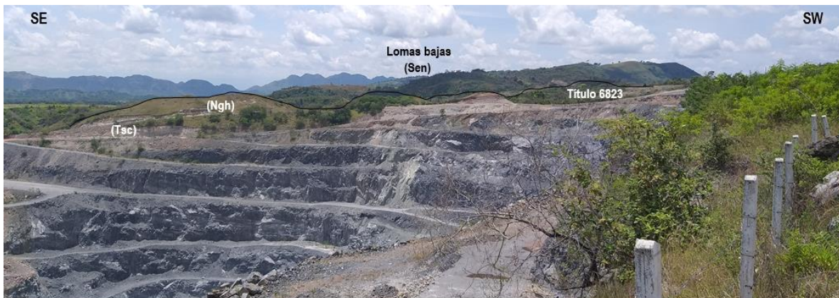
Fotografía 42. Lomas bajas de laderas cortas superficies cóncavas-convexas en rocas areniscas, arcillolitas de la formación Honda (Ngh) cubriendo discordantemente los depósitos de Caliche (Ngh) al sur del título minero 6823, mina La Esmeralda. punto de control 852. Coord. Este 4 766 343; Coord. Norte 2 033 866.
