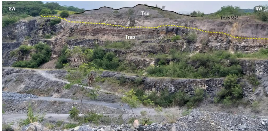
Fotografía 41. Lomas medias a bajas de laderas cortas superficies cóncavas-convexas en depósitos de Caliche (Tsc) cubriendo discordantemente a rocas de la formación Payandé (Trsp) parte central del título minero 6823, mina La Esmeralda punto de control 852. Coord. Este 4 766 343; Coord. Norte 2 033 866.
