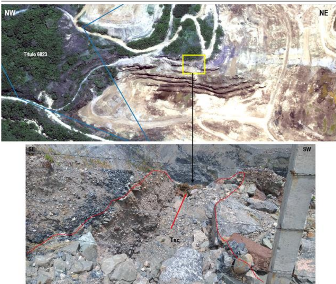
Fotografía 57. Erosión por cárcavamiento en talud suroeste del pit minero 4205, adyacente al título minero 6823, presente en la ortofoto de 2018 y evidenciado en labor de campo de septiembre de 2020, detonados por la escorrentía superficial en época de lluvias. Coord. Este 4 765 707; Coord. Norte 2 032 804.
