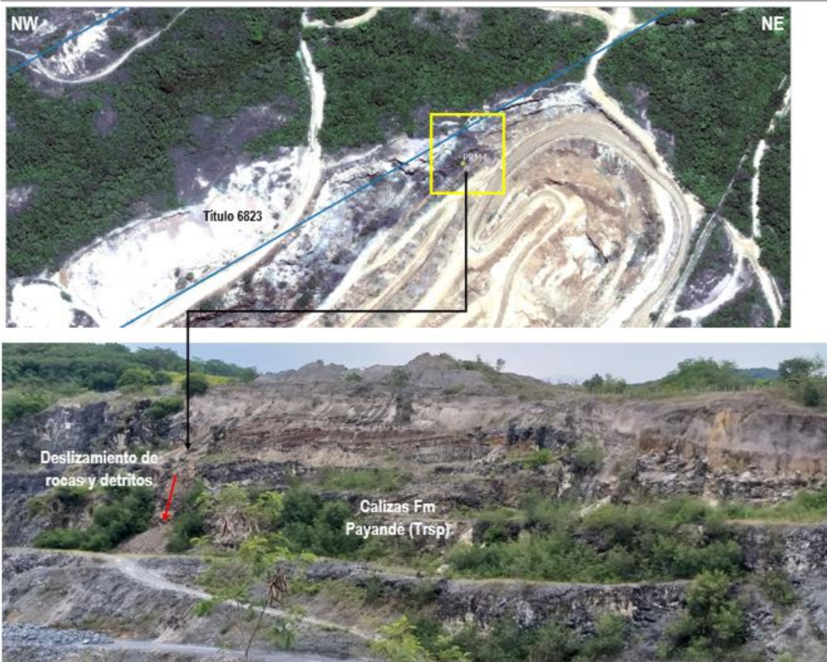
Fotografía 62. Proceso asociado a deslizamiento local, de rocas y detritos en talud noreste del pit minero 4205, calizas de la formación Payandé (Trsp), adyacente al título minero 6823, sin afectación directa sobre este título; identificado en 2018 como caídas de bloques PRM4. Coord. Este 4 766 675; Coord. Norte 2 0335 22.
