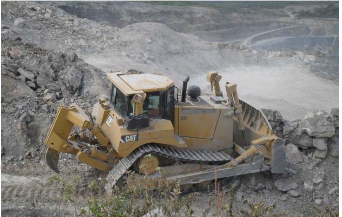
Foto 6.5. Preparación de Plazas con Bulldozer Cat D8.
