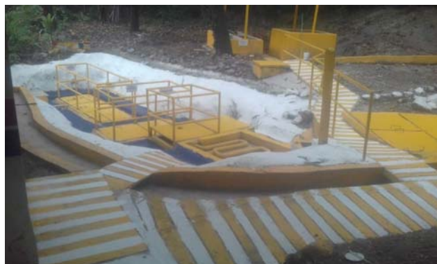
Foto 10.3 Planta de tratamiento de aguas residuales
