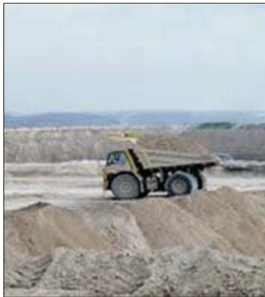
Foto 7.2. Volqueta transportando escombros (estériles) al sitio de retrolleado
