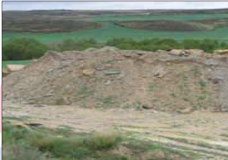
Foto 7.1: Pila típica de escombros en construcción
