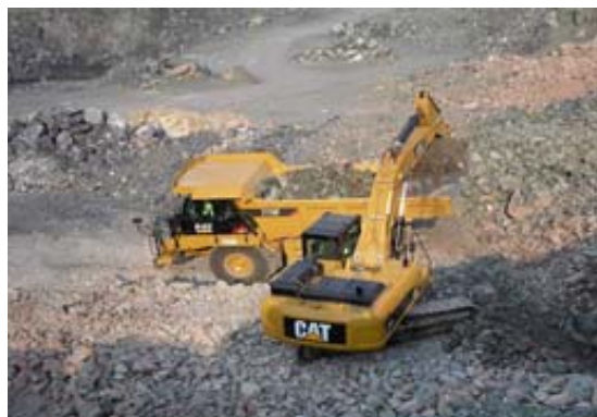
Foto 6.1. Arranque por medios mecánico retroexcavadora Cat 346 en etapa de desarrollo.
