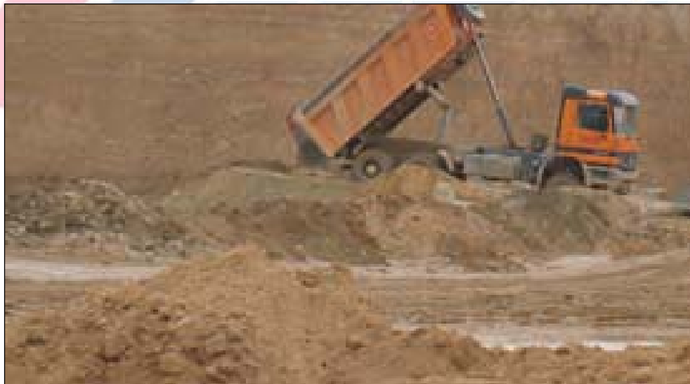
Foto 7.4. Volqueta doble troque vaciando material estéril sobre una plataforma o escombrera (método indirecto) conformada inicialmente por el método directo con escombros (vaciado con volco).
