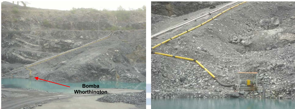
Fotos 10.1 y 10.2. Bombeo aguas lluvias en predios de la compañía.
