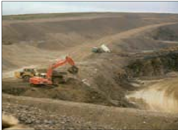
Foto 7.3. Sistema de vaciado indirecto de materiales areno-arcilloso y capa vegetal sobre los escombros de construcción mediante el módulo volqueta retroexcavadora.
