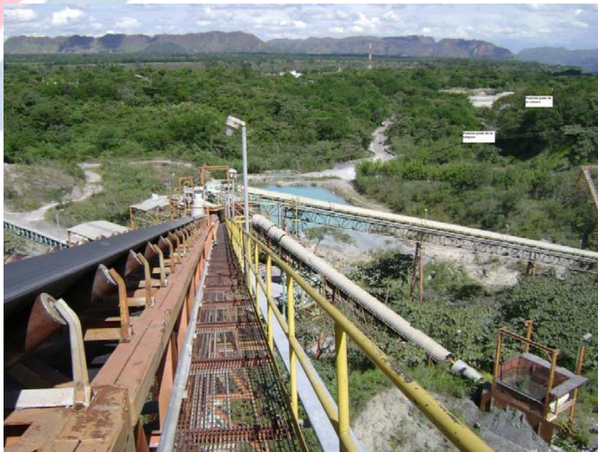
Foto 5.3. Infraestructura existente. Circuito de Trituración bandas.
