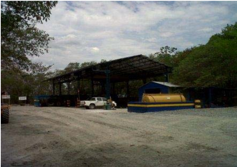
Foto 5.1. Infraestructura existente. Taller Equipos Móvil.
