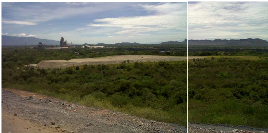
Foto 8.3. Terrazas en restauración Retrolenado Mina Puzolana – junio 2012.
