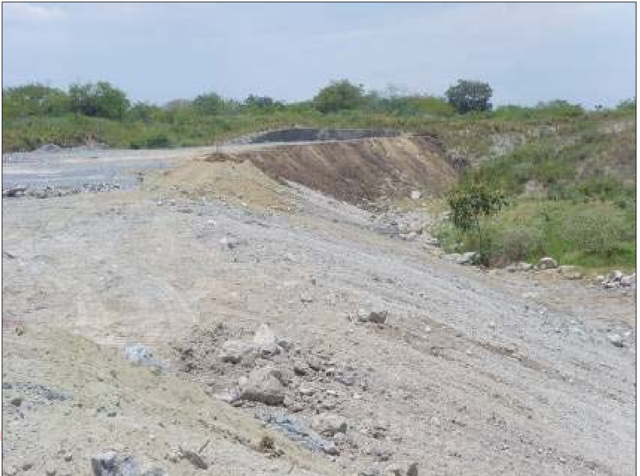
Foto 6.4. Disposición de suelo en taludes de reforestación
