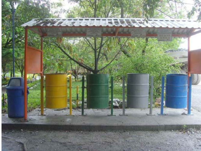
Foto 10.4. Acopio basculante existente en la Mina - COP.
