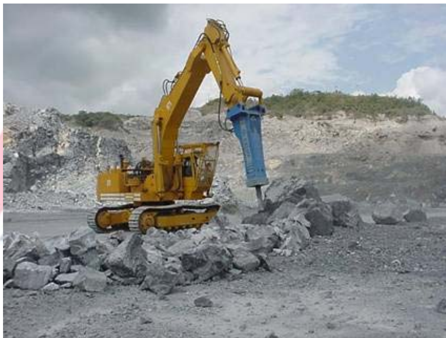
Foto 6.9. Ensayo arranque mecánico martillo Krupp 4000 HM
