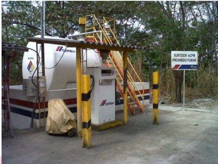
Foto 5.2. Infraestructura existente. Zona de despacho de combustibles
