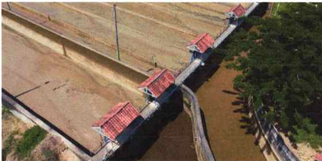
Figura 46. Compuertas salida del DESARENADOR CUCUANA - USOCOELLO.
