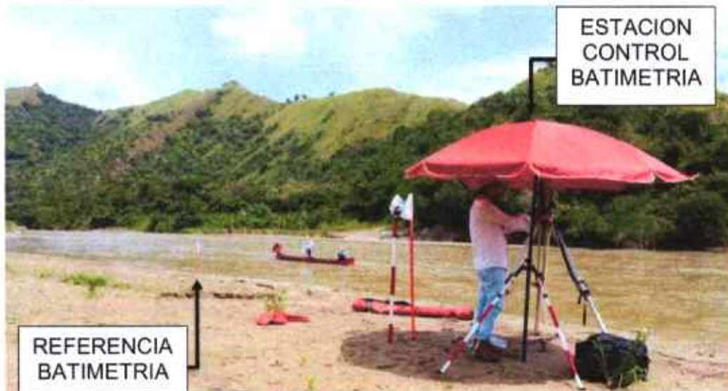
Figura 52. Trabajos de campo de batimetría aguas arriba - CYPH S.A.S.
