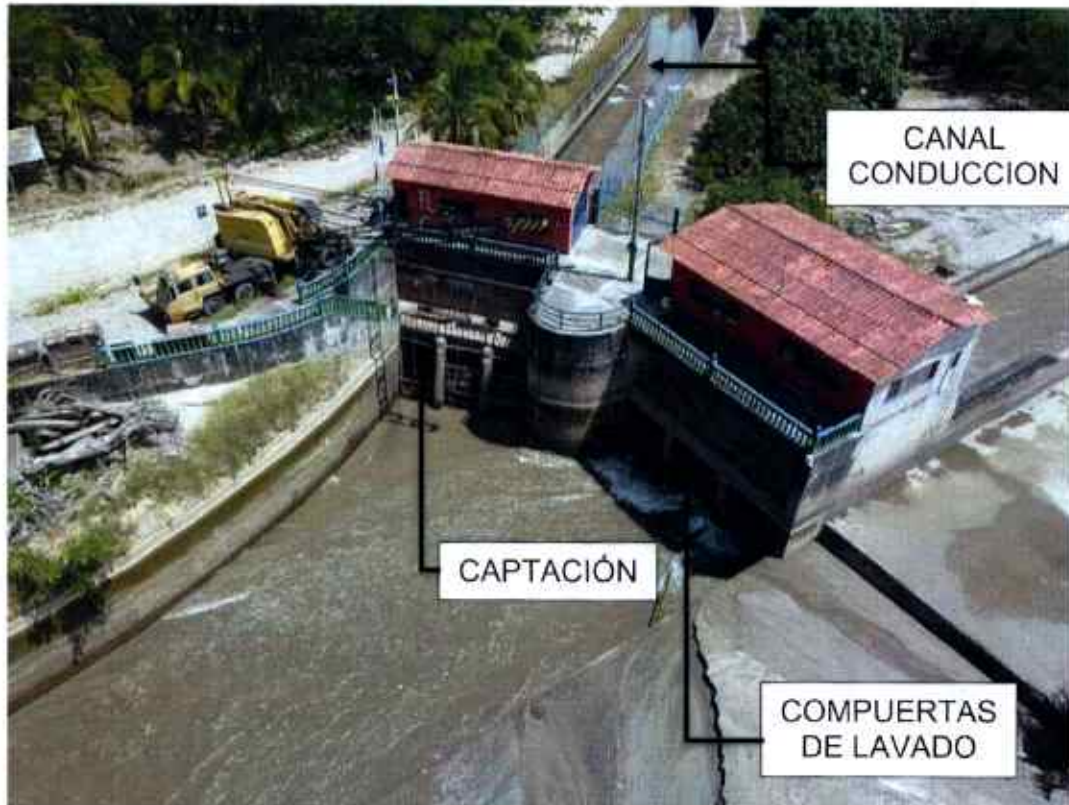
Figura 26. Vista aérea del sistema de Captación actual.
