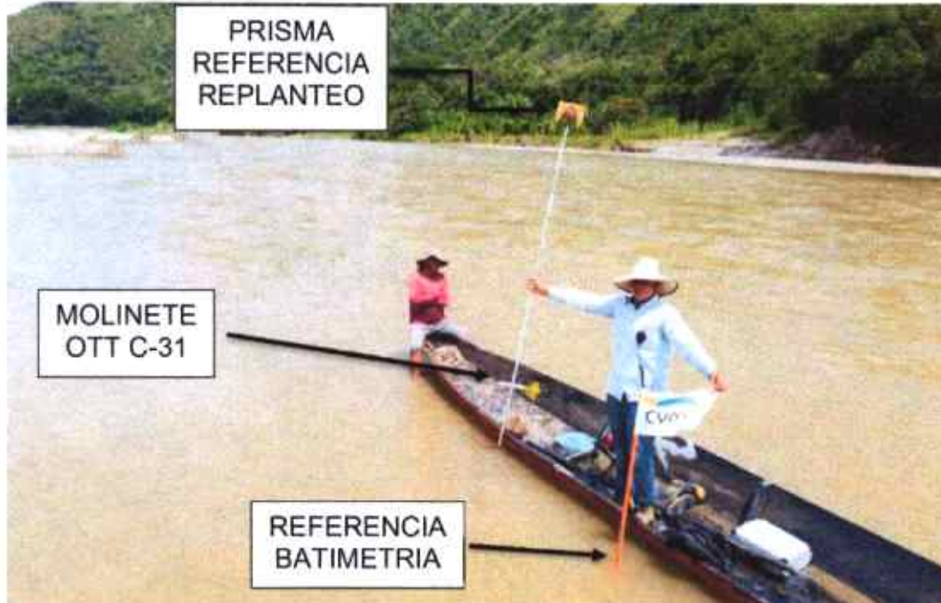
Figura 51. Trabajos de campo de batimetría aguas arriba- CYPH S.A.S.
