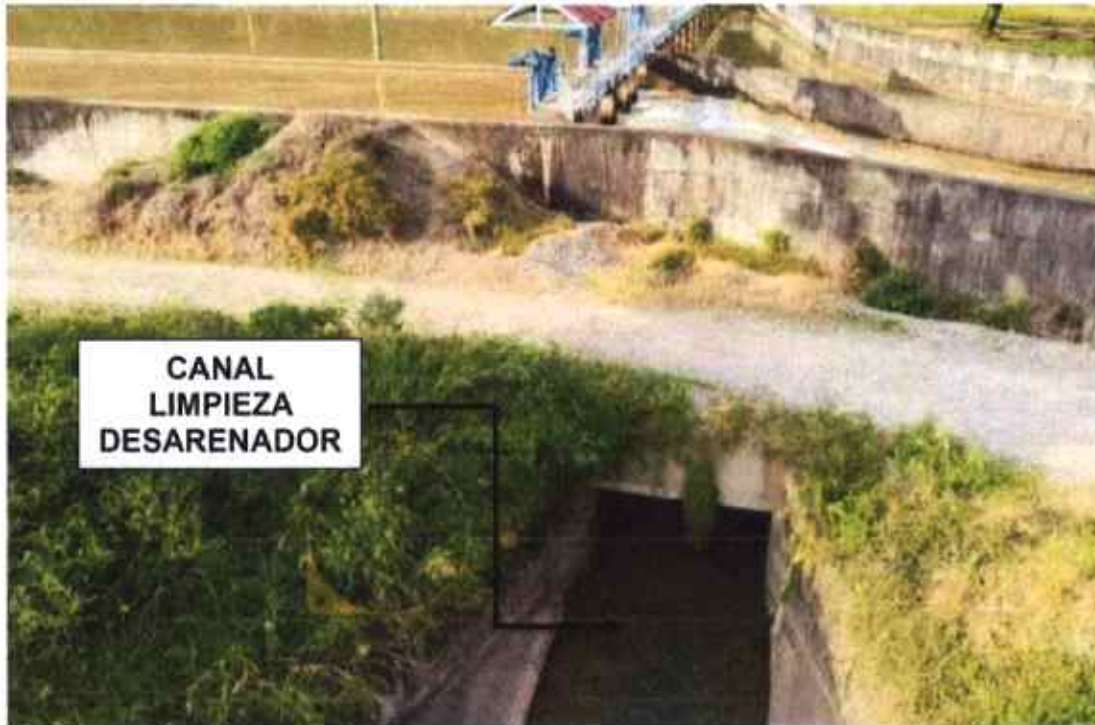
Figura 47. Canal de lavado del DESARENADOR CUCUANA - USOCOELLO.
