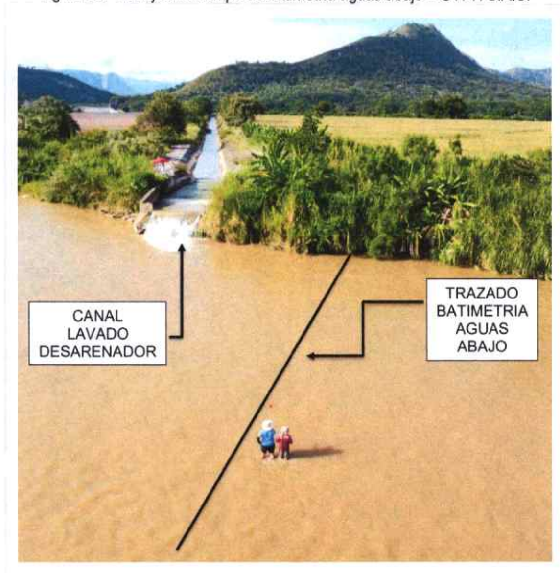
Figura 55. Trabajos de campo de batimetría aguas abajo – CYPH S.A.S.
