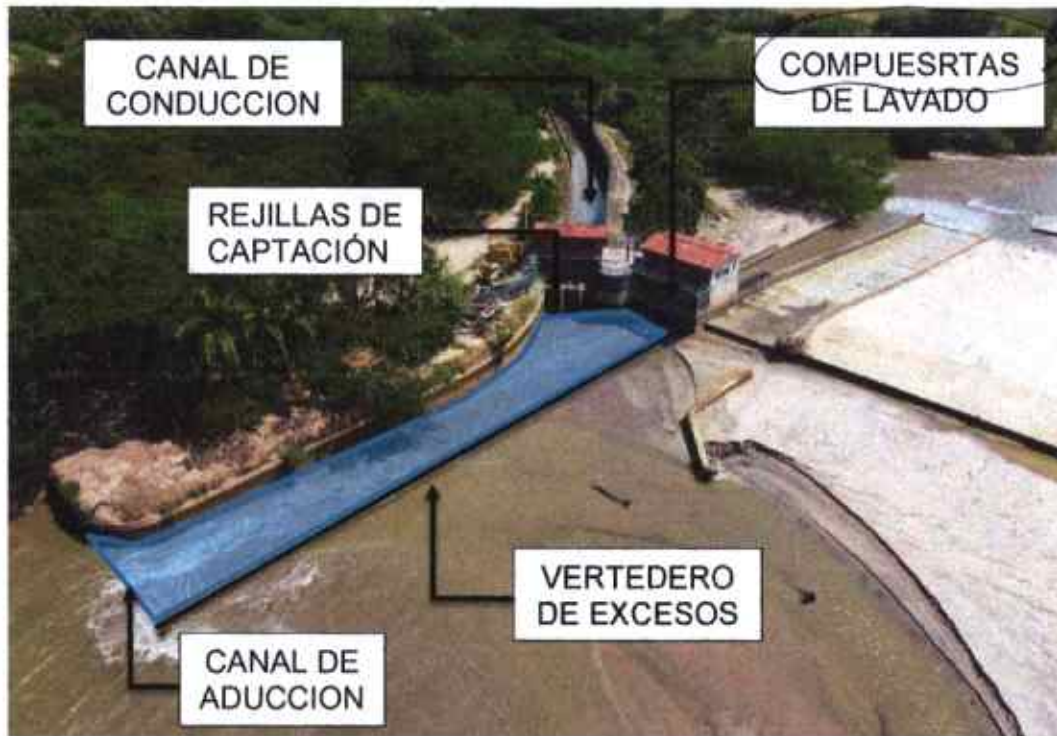
Figura 29. Vista aérea del sistema de Captación.
