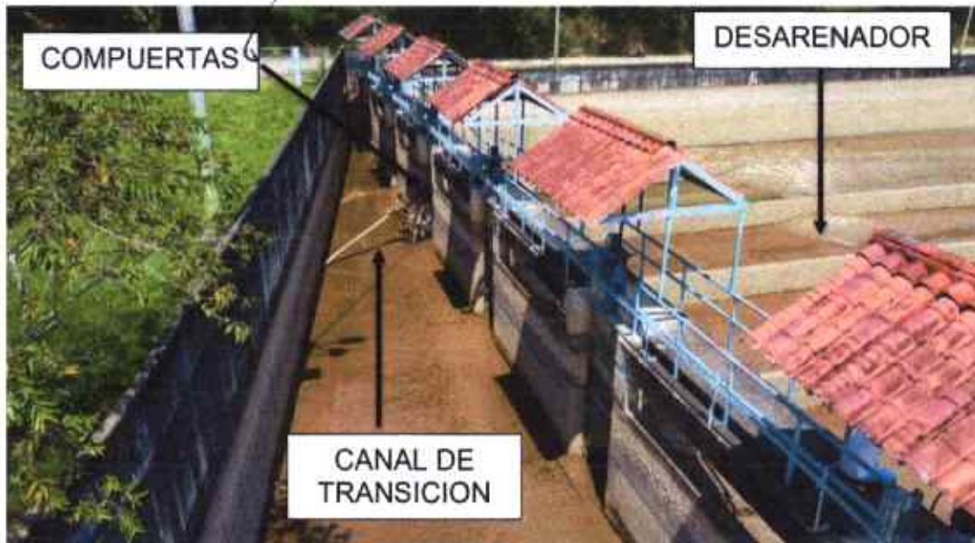
Figura 34. Vista aérea del canal de transición.
