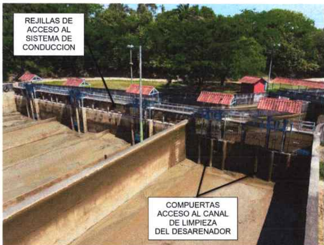
Figura 37. Vista aérea de salida del Desarenador.
