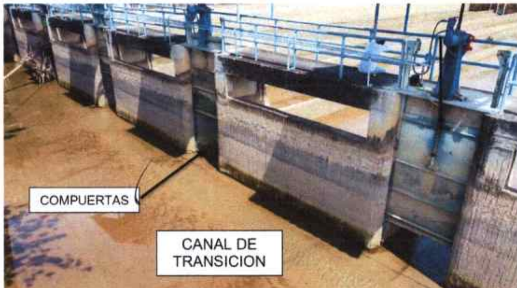
Figura 35. Vista aérea del canal de transición.
