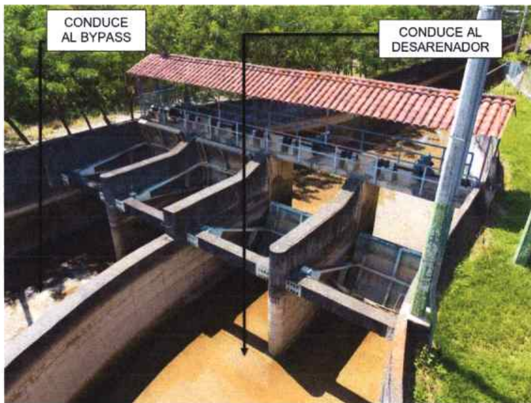
Figura 33. Vista aérea del canal de conducción.
