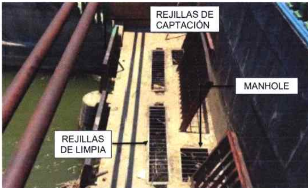
Figura 28. Vista lateral de la Captación.
