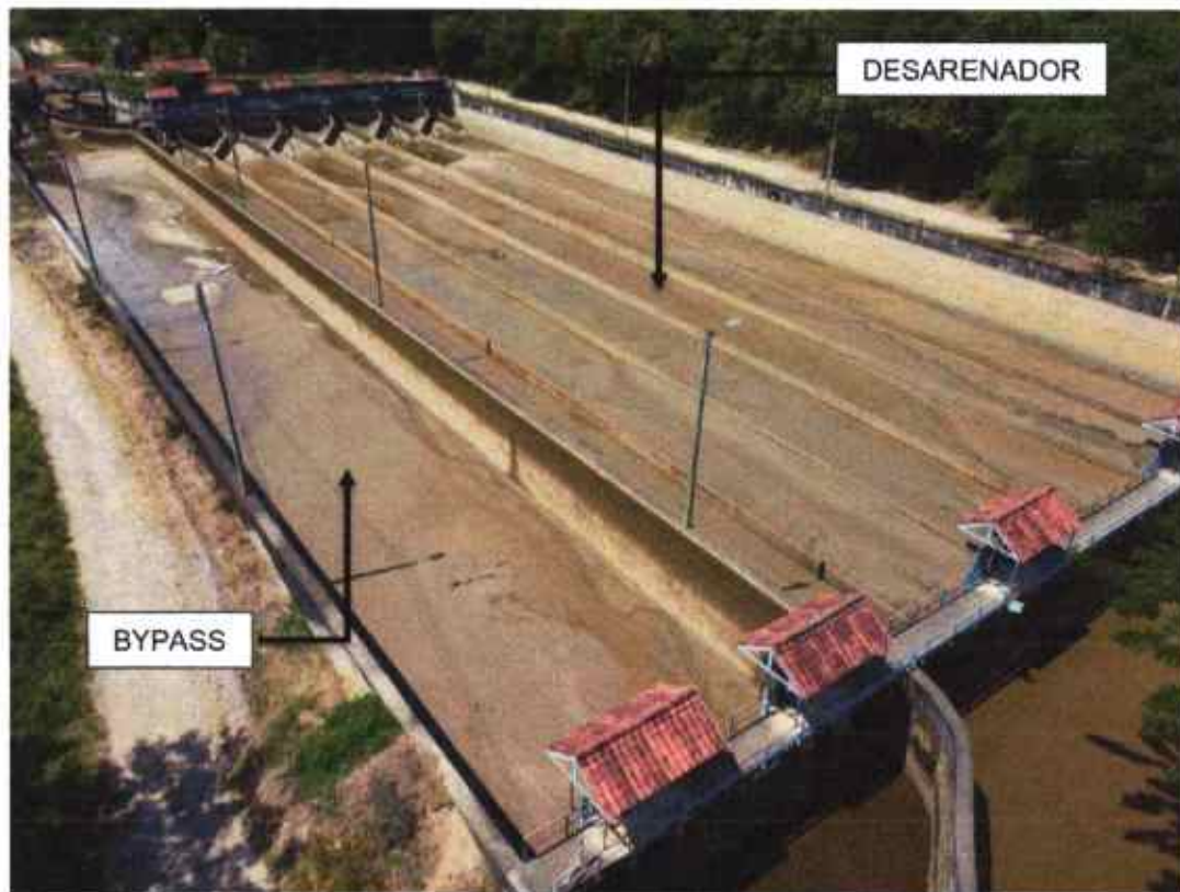
Figura 32. Vista aérea del Desarenador.
