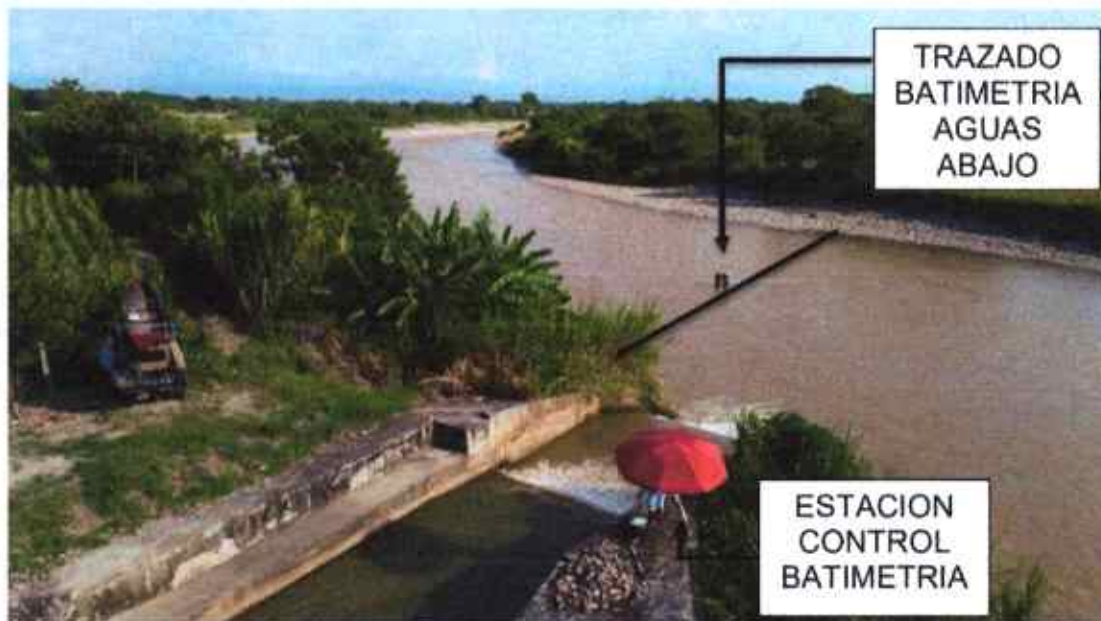
Figura 54. Trabajos de campo de batimetría aguas abajo – CYPH S.A.S.
