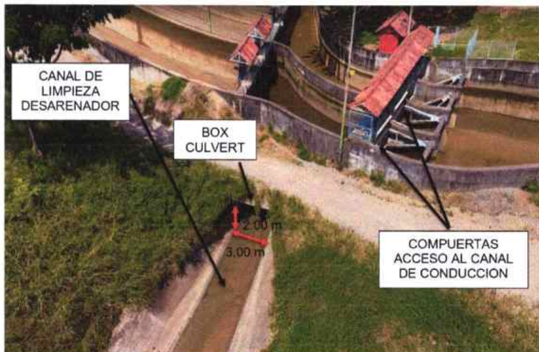
Figura 38. Vista aérea de salida del canal de limpieza del desarenador.
